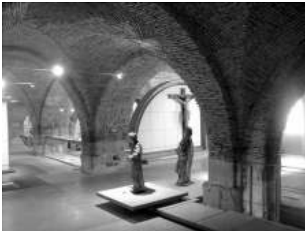
Figura 5. Museo de Cáceres. Edificio Casa de los Caballos. Sala de Arte Antiguo. Sótanos. Cáceres.
