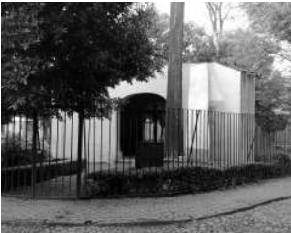
Figura 3. Fachada que da al poniente de la “cámara de los secretos”. Fotografía de Leonardo Zaldivar Icaza.
