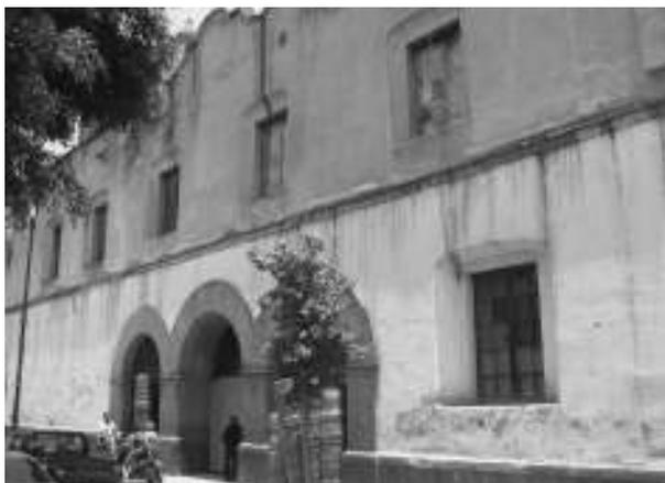
Figura 28. Aspecto de la fachada sur del claustro antes de las obras de remodelación y restauración; nótese los vanos, el pórtico con tres arcos y las almenas que remataban el pretil festoneado.
