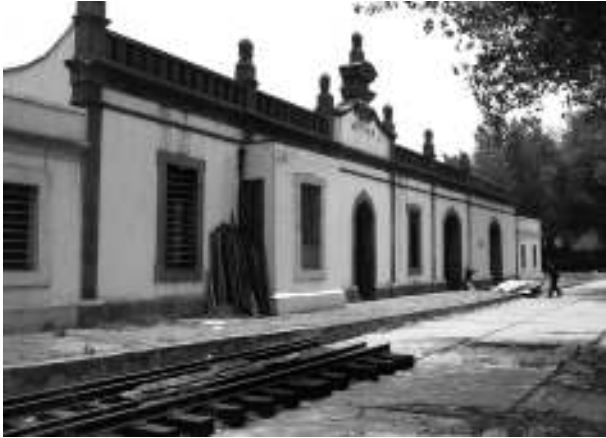
Figura 2. Estación de trenes “La Villa”.
