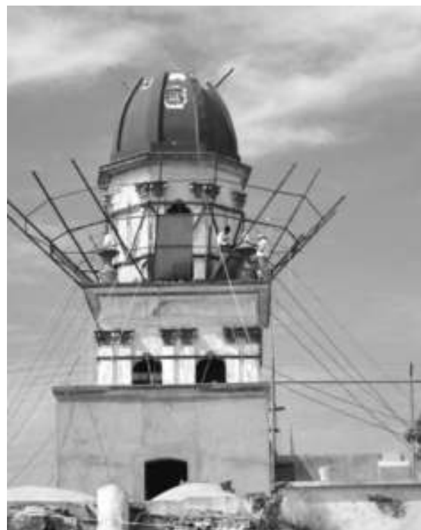
Figura 16. Proceso de demolición del segundo cuerpo de la torre campanario del templo mediante colocación de estructura de protección, 2004. Archivo de la SMH-Centro INAH Colima, exp. Templo del Sagrado Corazón, Sismo 2003.
