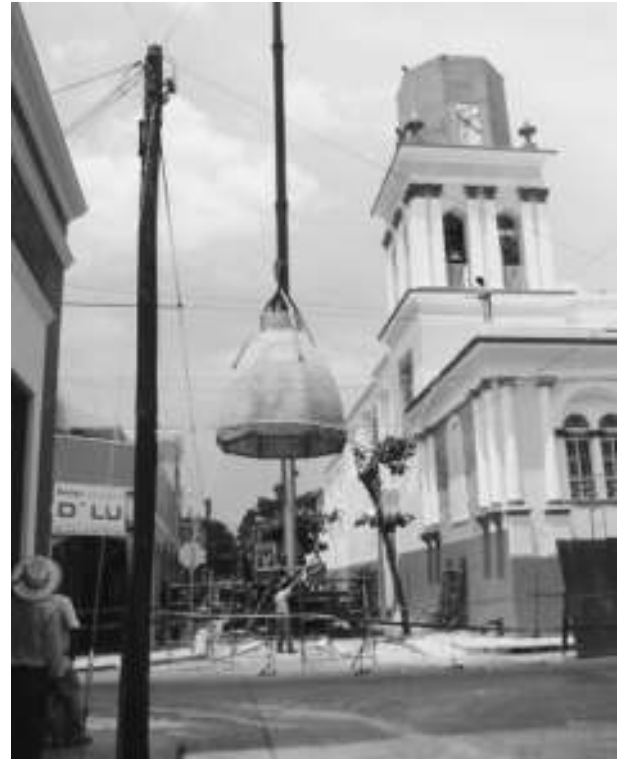
Figura 18. Proceso de construcción y colocación del segundo cuerpo de la torre, realizado con un sistema constructivo ligero que evitó sobrepeso a la estructura, 2004. Archivo de la SMH-Centro INAH Colima, exp. Templo del Sagrado Corazón, Sismo 2003.
