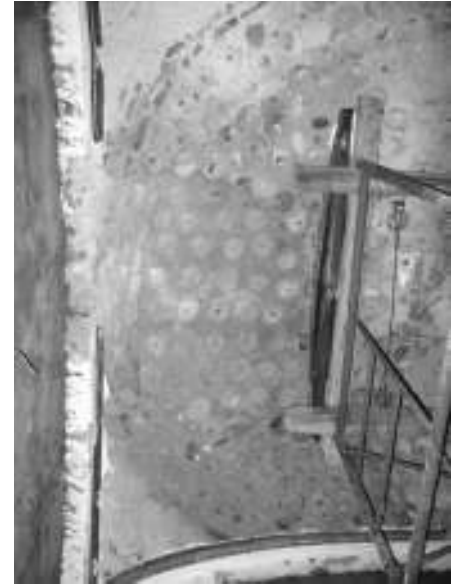
Figura 6. Sistema constructivo a base de cántaros de barro en bóvedas del inmueble. a) En exterior. b) Con apuntalamiento en interior, 2004. Archivo de la SMH-Centro INAH Colima, exp. Templo del Sagrado Corazón, Sismo 2003.
