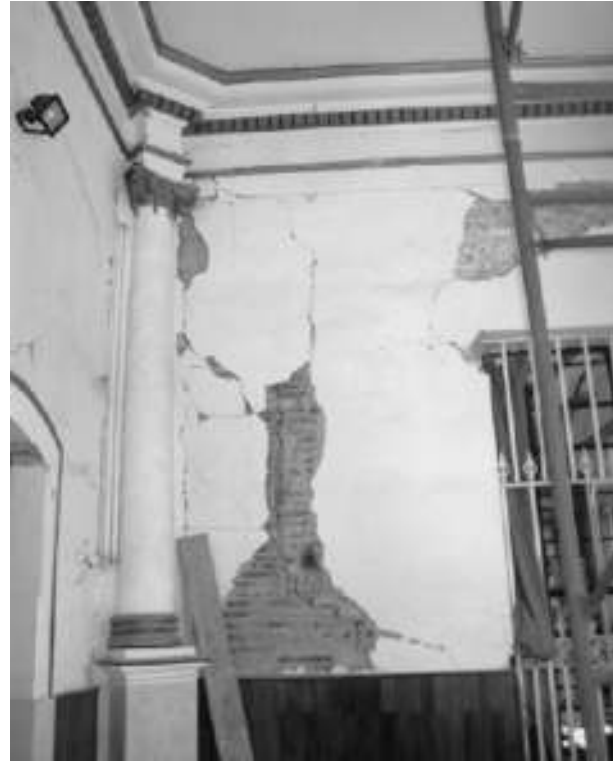
Figura 3. Daños provocados por el sismo en nave principal del inmueble, 2003. Archivo de la Sección de Monumentos Históricos (SMH)-Centro INAH Colima, exp. Templo del Sagrado Corazón, Sismo 2003.
