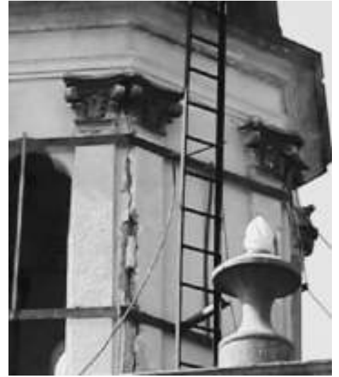
Figura 14. Detalle de daños en segundo cuerpo de la torre campanario del inmueble, producto del sismo de 2003. Archivo de la SMH-Centro INAH Colima, exp. Templo del Sagrado Corazón, Sismo 2003.
