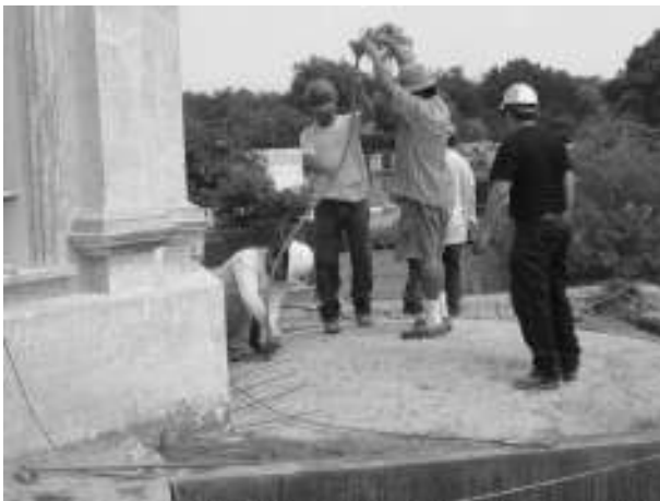
Figura 10. Trabajos de consolidación mediante inyección en bóvedas del inmueble, 2004. Archivo de la SMH-Centro INAH Colima, exp. Templo del Sagrado Corazón, Sismo 2003.
