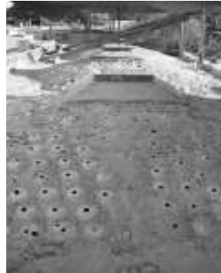
Figura 6. Sistema constructivo a base de cántaros de barro en bóvedas del inmueble. a) En exterior. b) Con apuntalamiento en interior, 2004. Archivo de la SMH-Centro INAH Colima, exp. Templo del Sagrado Corazón, Sismo 2003.
