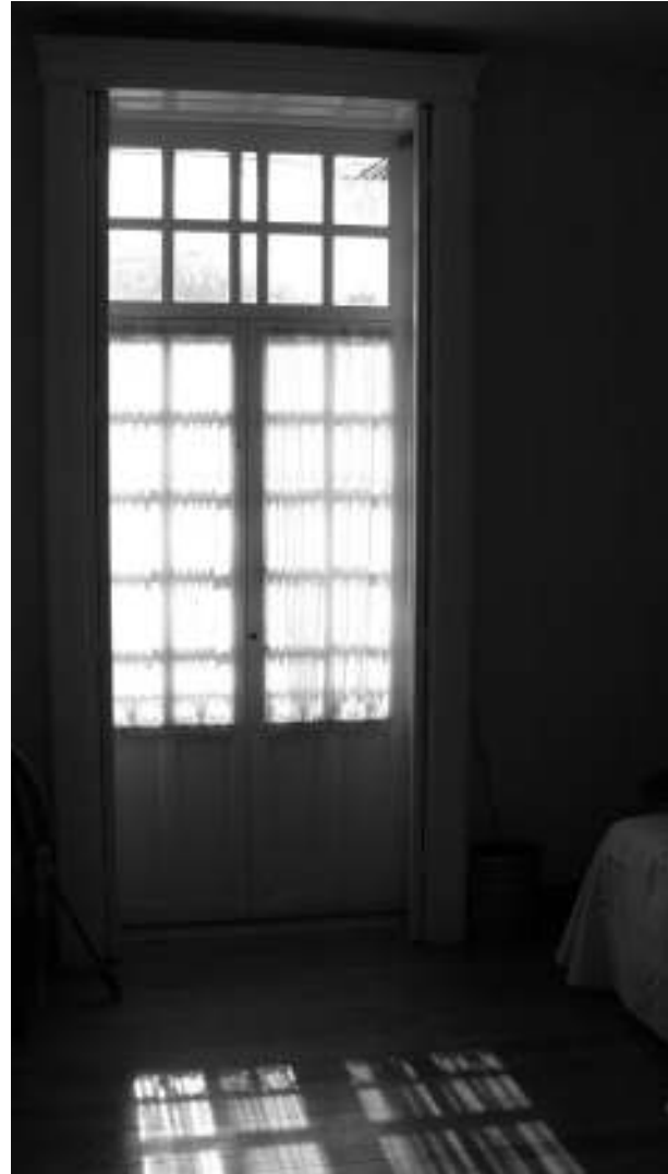
Figura 5. El balcón no ejercía grandes funciones sociales en Toluca, pero era un excelente mecanismo de captación y conservación de calor, debido a la combinación de vidrio y madera. Fotografía de René L. Sánchez.
