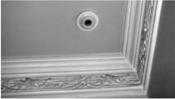
Figura 2. Los cielos rasos pueden formar una cámara de aire que reduce la oscilación térmica de la azotea. En este ejemplo, aunque restaurado y donde se aloja actualmente el Centro INAH Estado de México, conserva el criterio de cámara ventilada. Fotografía de René L. Sánchez.
