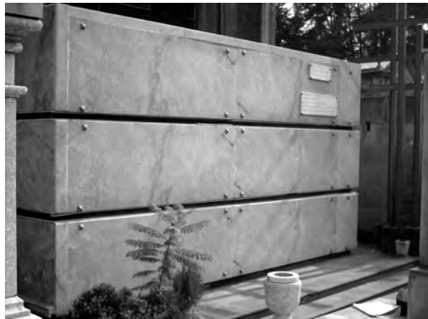
Figura 17. Construcción vertical para gavetas y nichos.
