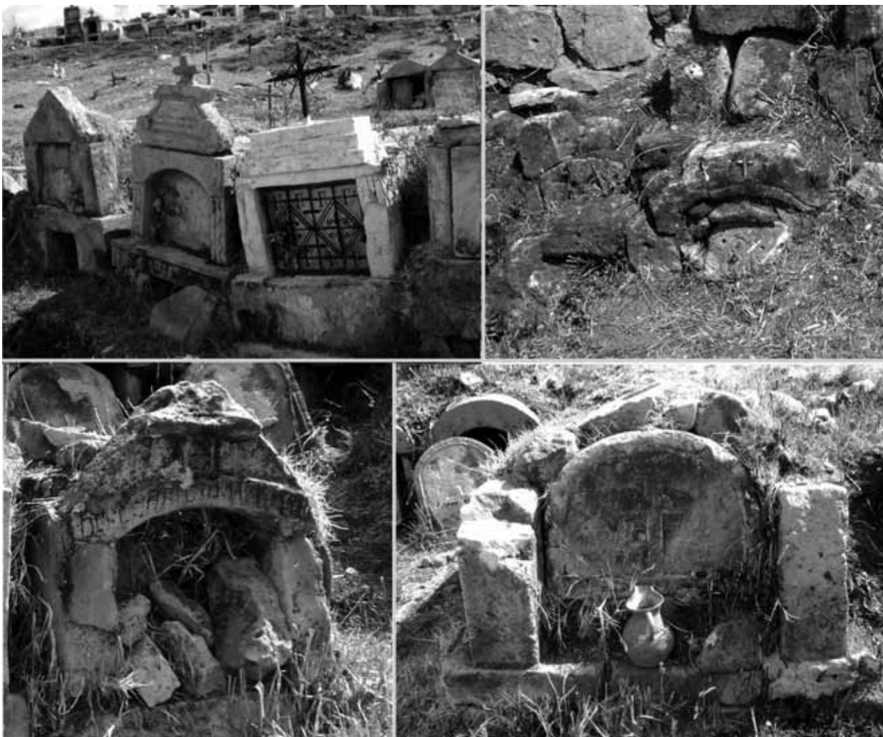
Figura 16. Muestras de deterioro de los elementos líticos: asentamiento diferencial por deficiencia geotécnica, soterramiento, daño mecánico (rotura) y colapso de bóvedas por fatiga de materiales.
