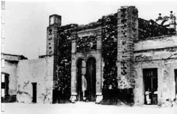
Figura 5. Fachada de la capilla del panteón de Santa Paula, antes de su demolición. Fototeca Constantino Reyes-Valerio, CNMHNAH.
