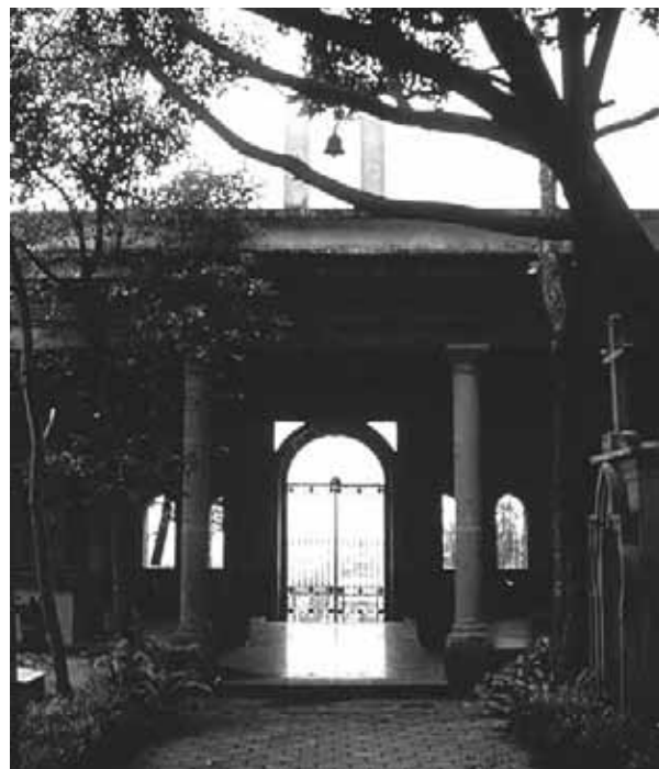
Figura 14. Vista desde el interior hacia el pórtico del edificio administrativo. Se reconoce en el arquitecto Macious un buen manejo de la iluminación natural, así como de integración con el contexto edificado preexistente. 2005.
