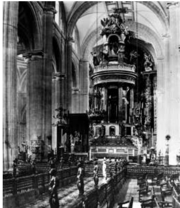
Figura 12. Fotografía del interior de la Catedral que permite analizar tanto el diseño del Ciprés de Lorenzo Hidalgo como la balastrada de la nave central que separa a los eclesiásticos de los fieles (véase también la fotografía del interior de la Catedral durante una ceremonia litúrgica). Fototeca de la CNMH-Conaculta- INAH, s.n.i.
