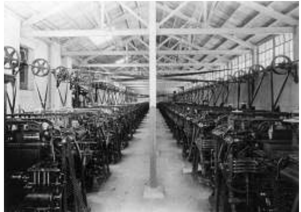
Figura 1. Departamento de telares mecánicos, salón "A". Fuente: Compañía de San Ildefonso, S.A., México, A. Briquet, 1899, s/f.
