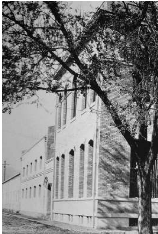
Figura 11. Fachada sur, ca. 1905.
