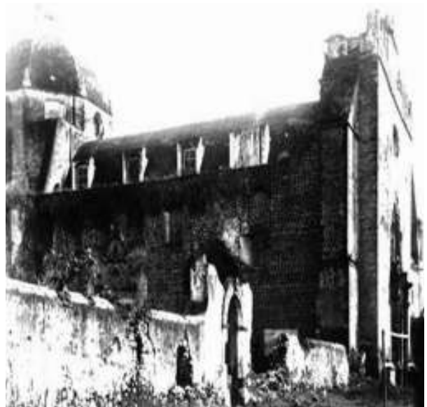
Figura 5. El templo y antiguo convento de San Bernardino de Siena es una construcción franciscana del siglo XVI que ha tenido severos problemas estructurales de conservación. Fototeca Constantino Reyes Valerio de la CNMH-INAH.
