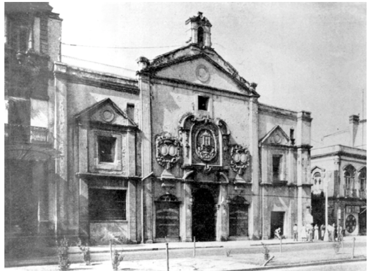
Templo de Corpus Christi. ca. 1941 (INAH -Fototeca de la CNMH. Impresión de Ramón Fernández)
