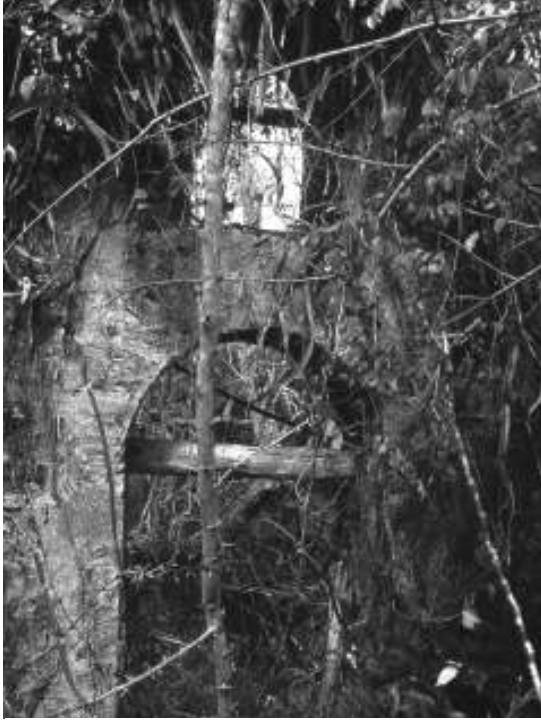
Figura 15. Detalle de la espadaña.
