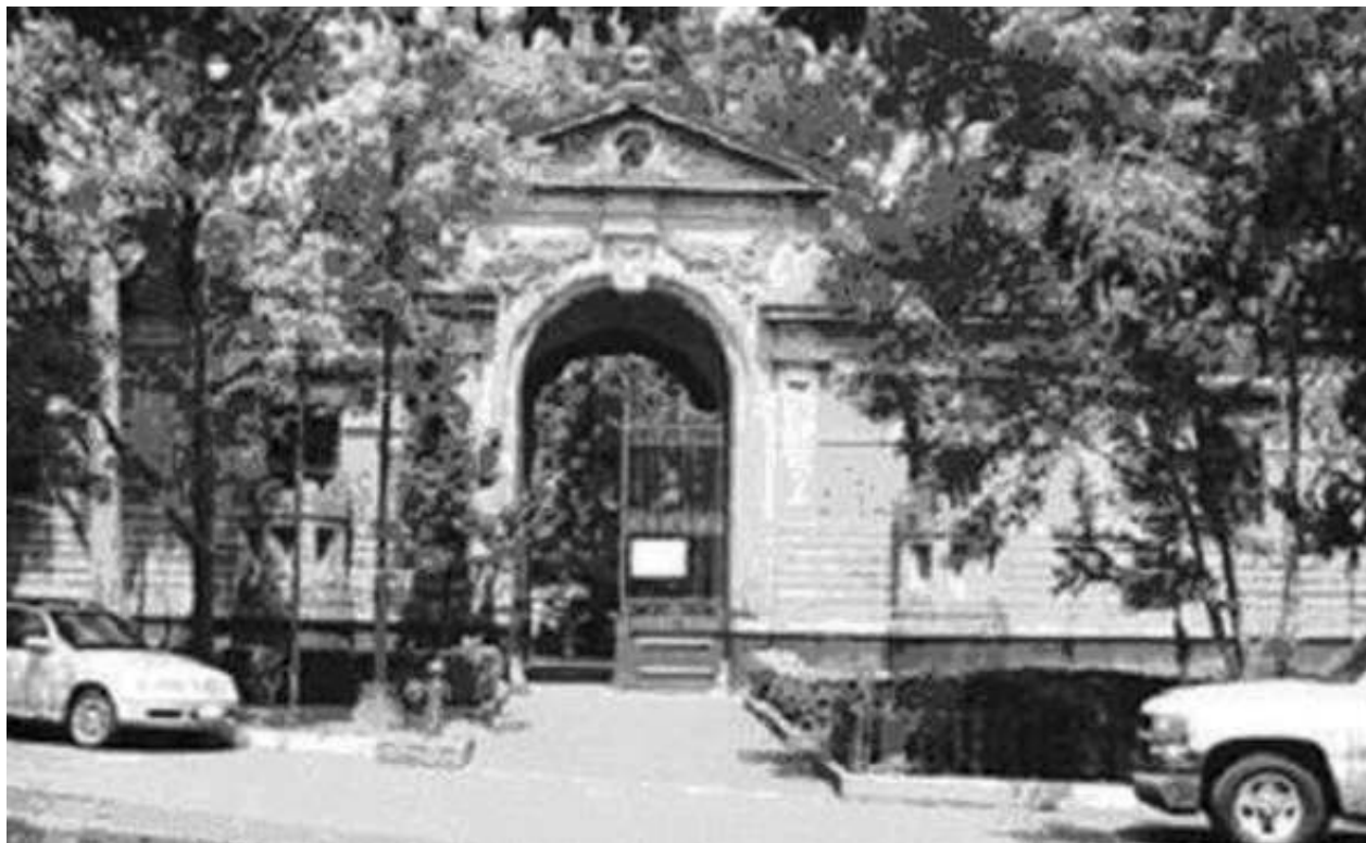
Fotografía 1. Entrada principal, siglo XVII; actualmente oficinas de mantenimiento. Fotografía: Luis Felipe Castro Muñoz Ledo, 2003.
