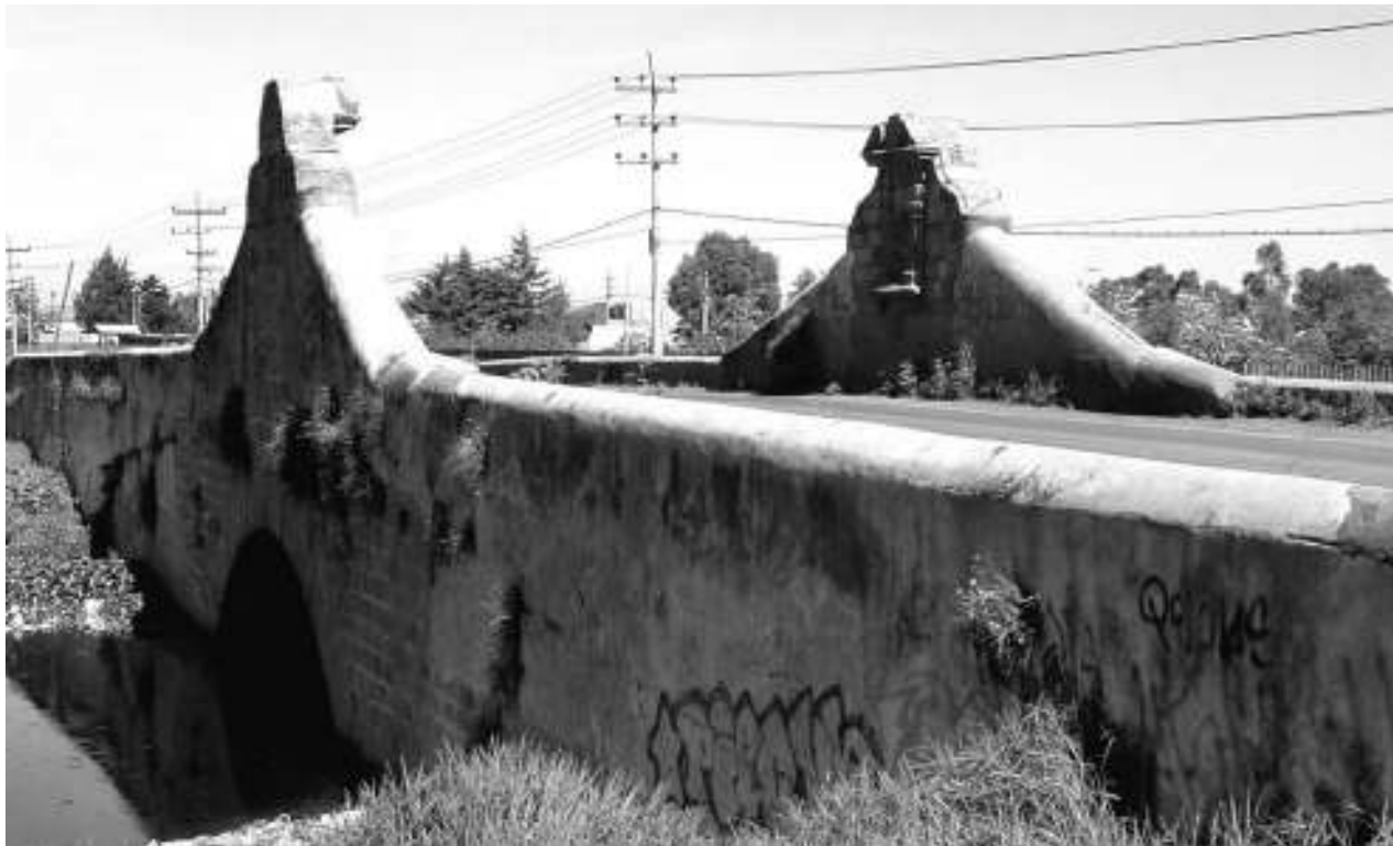
Figura 1. Vista superior del puente, que muestra el ancho de casi 6 m.
