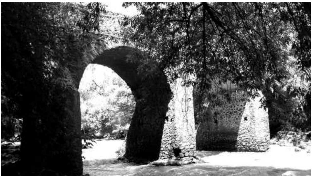
Figura 6. Vista de dos de los arcos centrales del puente de Batanes.
