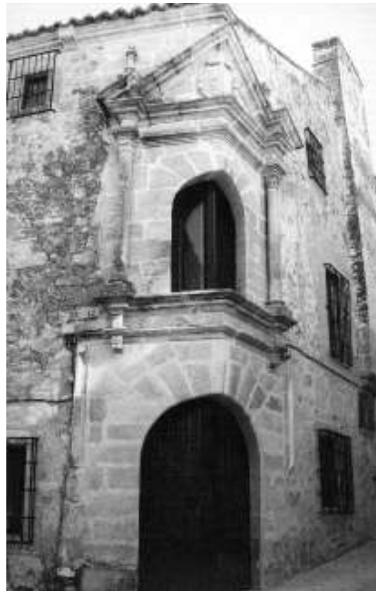
Figura 3. Balcón de la Casa de los Cháves-Calderón de Trujillo, realizado por Becerra.
