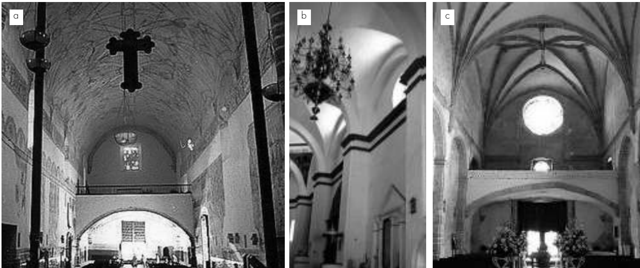
Figura 3. Tipos de bóvedas: a) Cañón corrido sin arcos, Catedral de Cuernavaca. b) Cañón con lunetos, Templo Santiago Apóstol, Jiutepec. c) Cañón de nervaduras, Templo Santo Domingo, Oaxtepec. Fuente: visita de campo (Natalia García).
