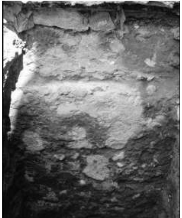
Figura 13. Sistema de contención norte con pilotes prehispánicos de la acequia de La Merced.
