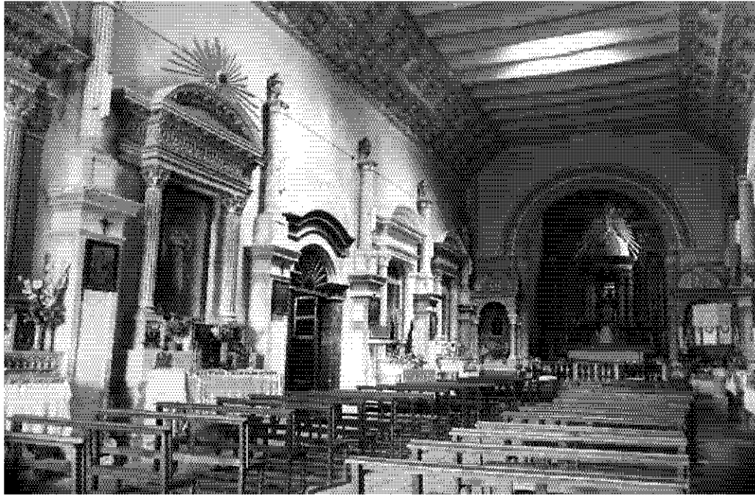
Ex convento de Santa María de los Reyes, Huatlatlauca, Puebla. Interior del templo. Foto: Constantino Reyes-Valerio, 1963. Fototeca de la CNMH, INAH, neg. CDXXII-9.
