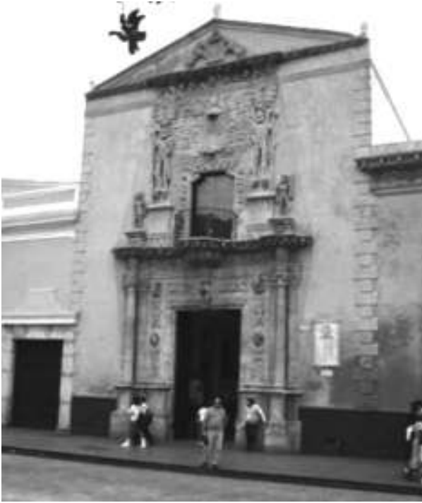
Figura 8. Portada de piedra después de aplicar el rayo láser y el agua de cal. Fotografía: Arturo Román K.
