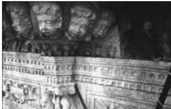
Figura 7. Área de la clave del acceso y la ménsula del balcón, terminada la aplicación del rayo láser. Fotografía: Arturo Román K.
