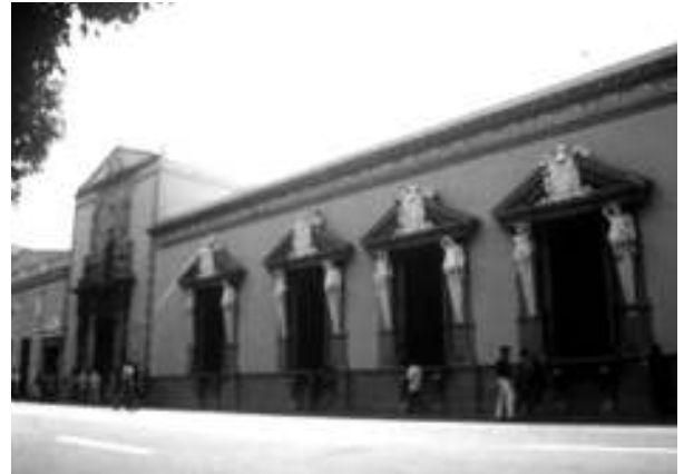
Figura 2. Vista de la fachada de la Casa de Montejo, antes de iniciar los trabajos de restauración de la primera etapa, en 1998. Fotografía: Arturo Román K.
