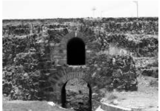
Figura 7. Compuerta principal de la presa (vista de la fachada sureste). Se puede apreciar la cantería en los arcos de medio punto. El recubrimiento del canal es reciente.
