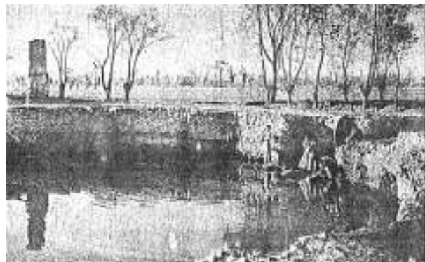
Figura 11. Acueducto de Zancopinca rodeado por su brocal de piedra. Imagen de Víctor M. Martínez, "La alberca de Zancopinca", en Alrededores de México , México, 1941, mapa 83, pp. 43-44.
