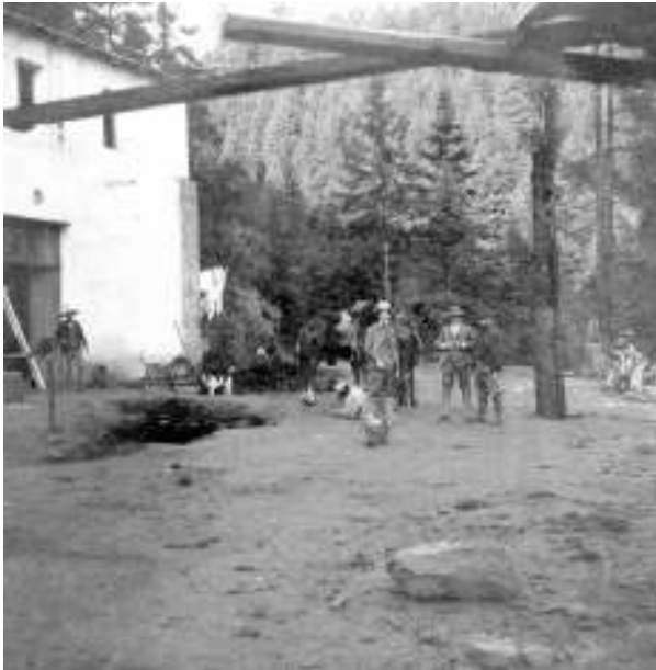
Figura 4. Vista de una parte del edificio de mampostería con dos pisos y techos de viguetas de acero que se encontraba cerca del salto de Xalancocotla. AHA, Aprovechamientos Superficiales, caja 4288, exp. 57263, f. 162.
