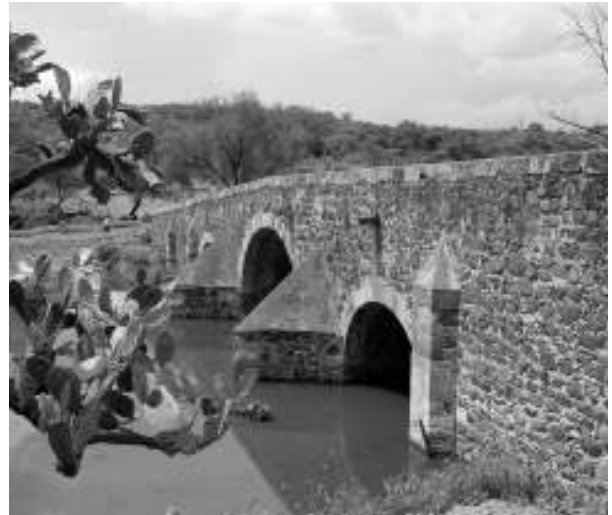
Figura 4. Tajamares pronunciados a ambos lados del arco central del puente de Calderón. Fotografía de Guillermo Boils Morales, agosto de 2006.
