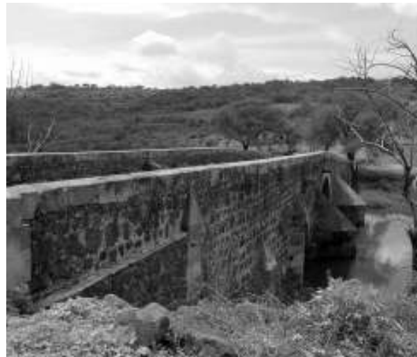
Figura 6. Pretil del puente de Calderón, desde el norte, apreciándose todavía una leve pendiente, suavizada por modificaciones, que se notan en su mampostería. Fotografía de Guillermo Boils Morales, agosto de 2006.
