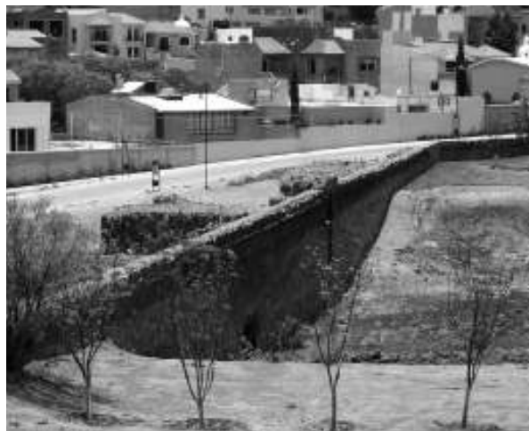
Figura 1. Vista norte-sur de la presa de Bernárdez.
