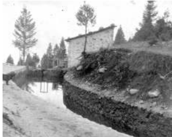
Figura 5. Canal que abastecía las turbinas de la fábrica La Hormiga. AHA, Aprovechamientos Superficiales, caja 4288, exp. 57263, f. 162.
