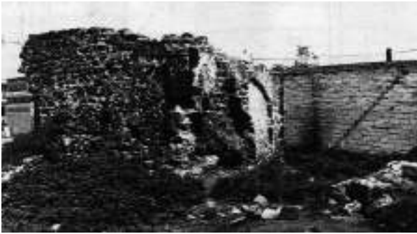
Figura 8. Muros formeros del molino de papel de Culhuacán (ca. 1943). Fototeca de la CNMH-INAH.
