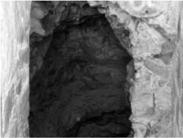
Figura 6. Túnel del segundo acceso de la cámara 9 en relación con el plano de planta de la presa (véase figura 2). Es también el último acceso desde el punto "O" del levantamiento.
