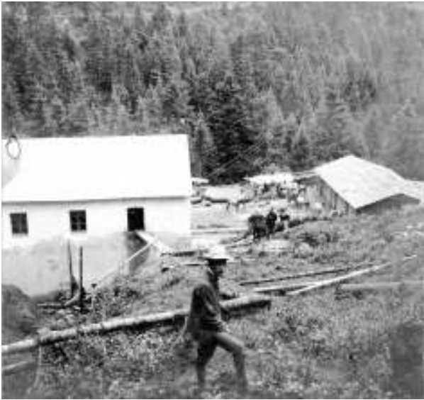
Figura 6. Planta eléctrica de La Hormiga. AHA, Aprovechamientos Superficiales, caja 4288, exp. 57263, f. 162.
