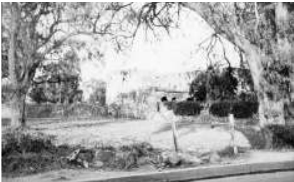
Figura 4. Aspecto del convento de Culhuacán en 1940. Fototeca de la CNMH/INAH.
