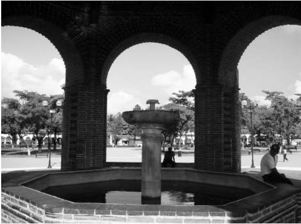
Figura 18. La pila que surte de agua y el recipiente octagonal cubiertos por una cúpula. Fotografía de Fredy Ovando Grajales.
