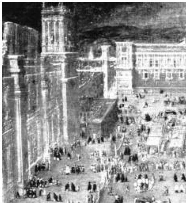
Figura 3. Cristóbal de Villalpando, Vista de esquina oriente de la Catedral de México , detalle. Tomado de Juana Gutiérrez Haces, et al., Cristóbal de Villalpando. Catálogo razonado , México, Fomento Cultural Banamex/IIUNAM/CNCA, 1997, p. 275.
