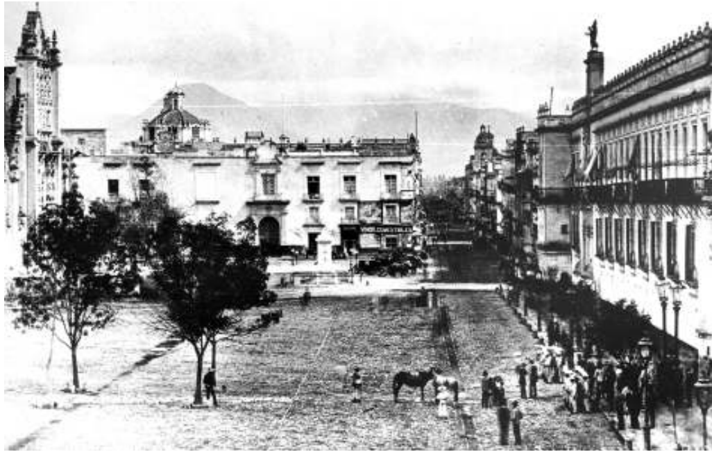
Figura 6. Vista del Colegio Seminario y del Colegio de Infantes, ca. 1890. FCNMH. CR Catedral exterior, XXVI-80.
