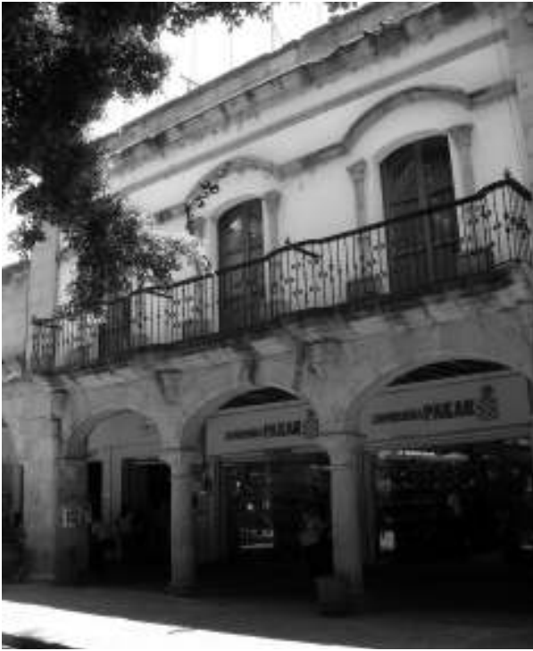
Figura 2. Fachada de la casa identificada como la de don Cristóbal Martínez en los portales en la Plaza Mayor de la ciudad de Oaxaca. Fotografía de Gerardo López Nogales.
