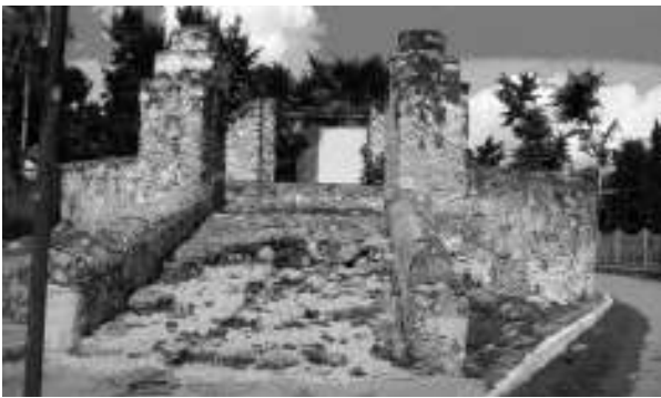
Figura 22. Noria pública de tiro descubierta (acceso principal). Vista desde el sur. Mama, Yucatán. Fotografía de José Manuel Chávez Gómez.
