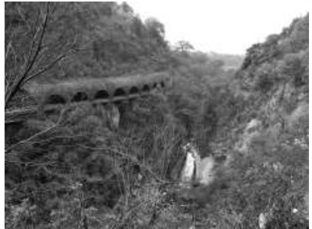
Figura 15. El moderno túnel-viaducto "Pensil". Fotografía de Dirk Bühler.
