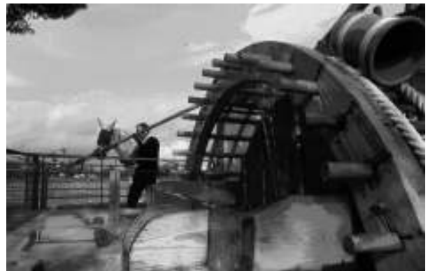
Figura 41. Reconstrucción del ingenio y consolidación de la arquitectura de la noria de Huerto Pío, Alicante, España. www.fundacionsierraminera.org/proyectos/huertopio/quees/quees.asp?opcion=2 .
