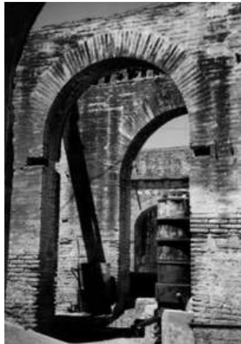
Figura 13. Hacienda y fábrica en Nayarit (ca. 1840-1910). Arquitectura tipo hacienda de la fábrica "Bellavista", Tepic (ca. 1843). Se aprecia detalle de la caldera de vapor vertical. Fotografía de Humberto Morales.
