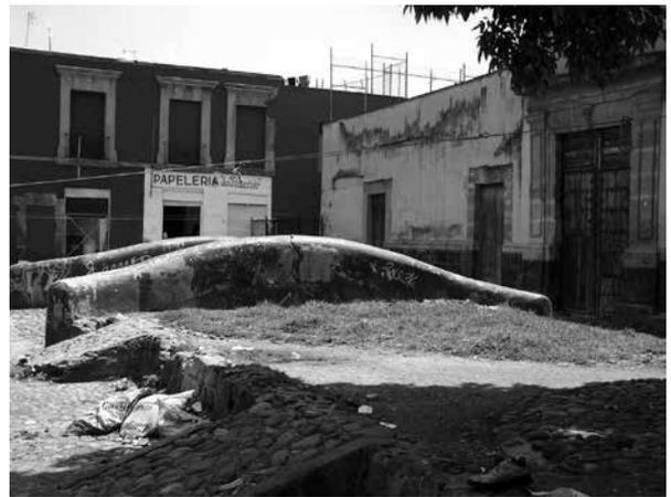
Figura 5. Fractura en el pretil sur del puente hacia el centro del mismo, cuatro años antes de la intervención de 2009. Foto de Guillermo Boils, julio de 2005.
