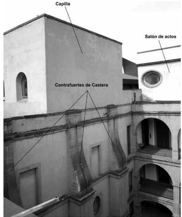
Figura 4. Salones de doble altura y contrafuertes en el patio sureste.
