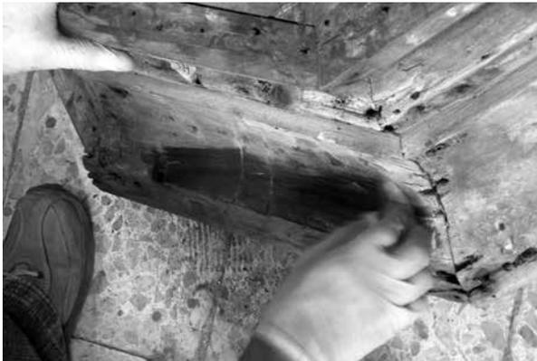
Figura 20. Limpieza de la superficie de la madera con solventes orgánicos.
