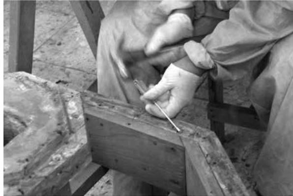
Figura 19. Eliminación de clavos de metal.
