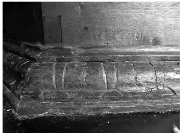
Figura 28. Misma zona de resane que en la figura 27, al concluir la aplicación de acabado y reintegración de color.
