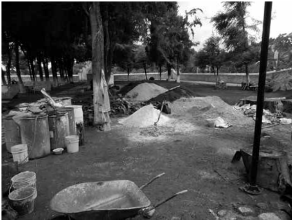
Figura 3. Se aprecia en primer término una pequeña mezcla de cal, atrás los montones de arenas rojas, negras y el caliche, de origen volcánico. Fotografía de Mario Córdova Tello.
