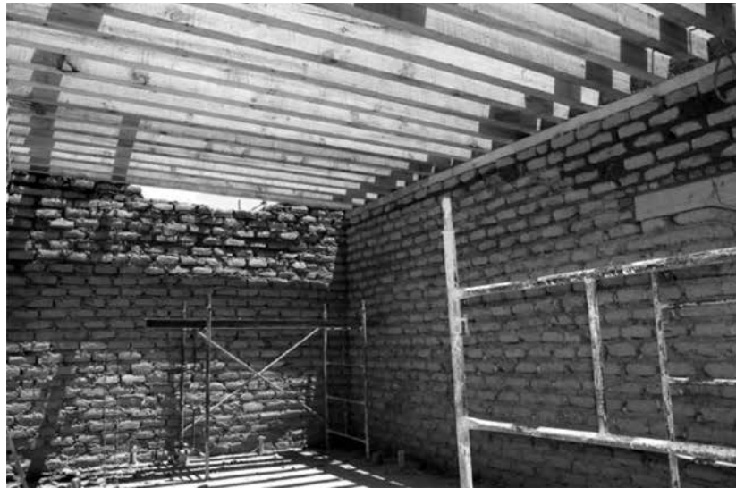
Figura 15. Fabricación de cubiertas en entrepiso con vigas de madera de pino. Fotografía de Alberto Ramírez Ramírez.
