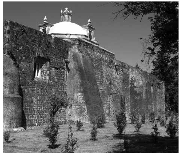
Figura 21. Contrafuertes sobrepuestos al muro norte del templo de y a la esquina noreste del muro testero de Santo Domingo de Guzmán Hueyapan. Fotografía de Mario Córdova Tello.
