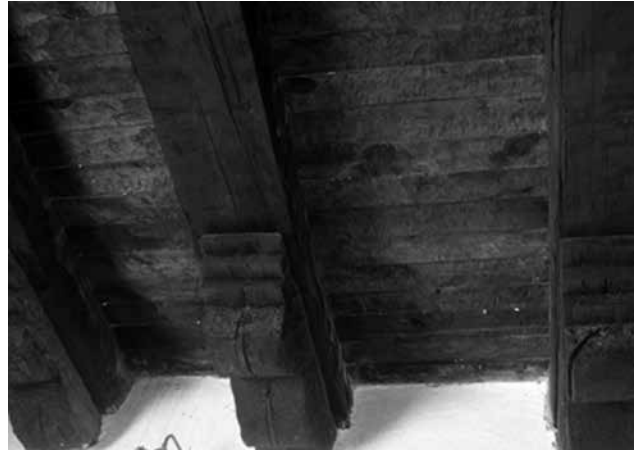
Figura 4. Iglesia de la misión de Oquitoa. La imagen de la izquierda muestra un entrepiso falso a base de un plafón de varas de carrizo; a la derecha un entablado. En algunos casos también se llegó a utilizar sobre la vigería de madera el petate de palma. Desde luego la utilización de los materiales dependía de su disponibilidad y de la rapidez por cubrir el espacio. Fotografías de Francisco Hernández.
