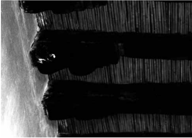
Figura 4. Iglesia de la misión de Oquitoa. La imagen de la izquierda muestra un entrepiso falso a base de un plafón de varas de carrizo; a la derecha un entablado. En algunos casos también se llegó a utilizar sobre la vigería de madera el petate de palma. Desde luego la utilización de los materiales dependía de su disponibilidad y de la rapidez por cubrir el espacio. Fotografías de Francisco Hernández.
