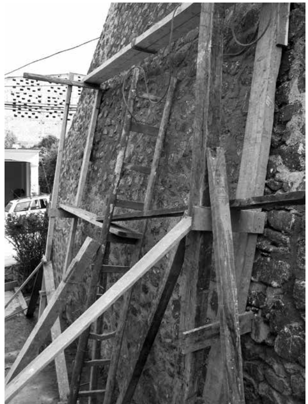
Figura 1. Andamios de madera sobre la fachada poniente del basamento del conjunto conventual de San Juan Bautista Tetela del Volcán. Fotografía de Mario Córdova Tello.
