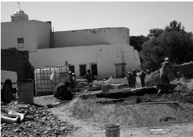
Figura 6. Trabajos en la parte posterior del inmueble con jornaleros de Sedesol. Fotografía de Alberto Ramírez Ramírez.
