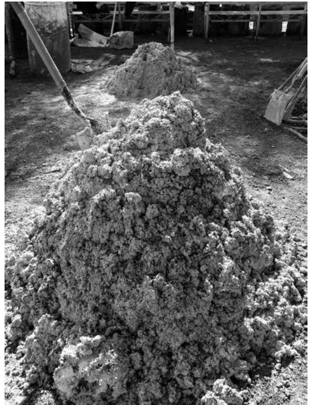
Figura 4. Mortero de cal hidratada y tezontle negro, empleado para los rellenos de los muros de la barda atrial del convento de San Juan Bautista Tetela del Volcán. Fotografía de Mario Córdova Tello.
