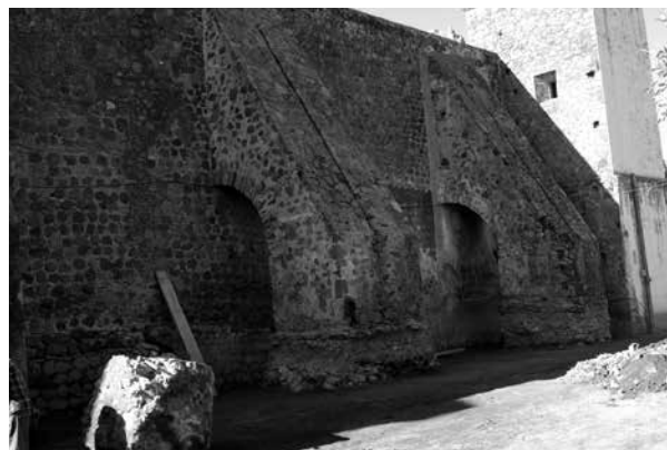
Figura 19. Contrafuertes adosados al muro norte del templo, apoyos sobre los que también descargaba el peso de la nueva bóveda del templo de San Juan Bautista Tetela del Volcán. Fotografía de Mario Córdova Tello.
