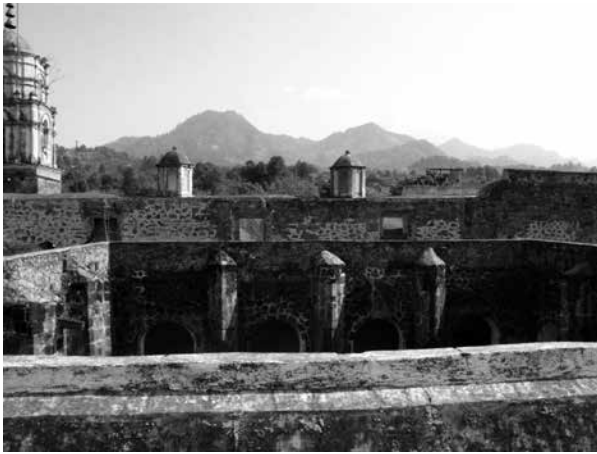
Figura 16. Muestra en segundo plano, los vanos adintelados de lo que fuera el claustro alto de San Juan Bautista Tetela del Volcán.
