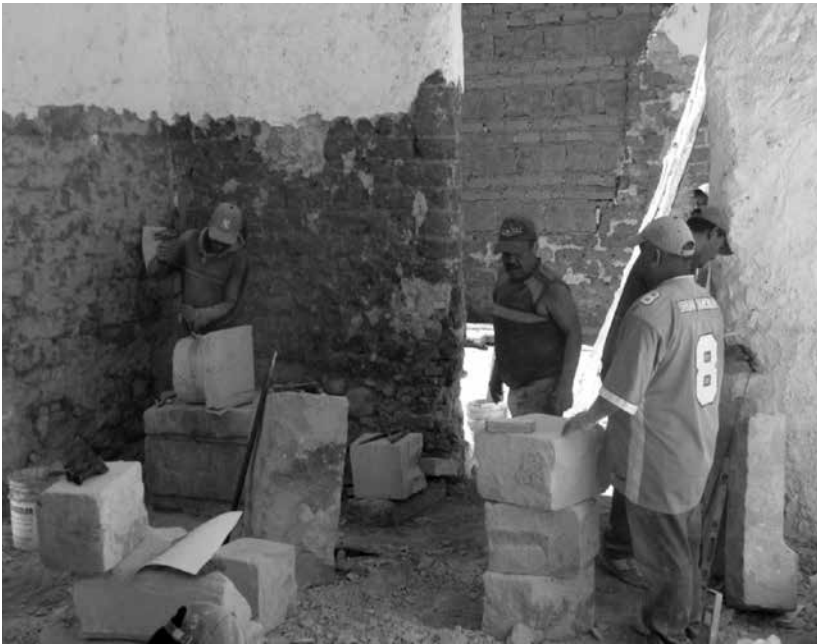
Figura 17. Recuperación y restitución de elementos de cantería. Fotografía de Alberto Ramírez Ramírez.
