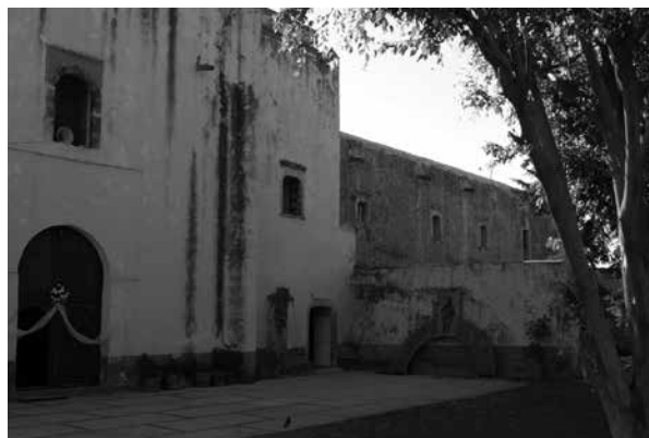
Figura 7. Fachada principal del templo de San Juan Bautista Tetela del Volcán. Fotografía de Mario Córdoba Tello.
