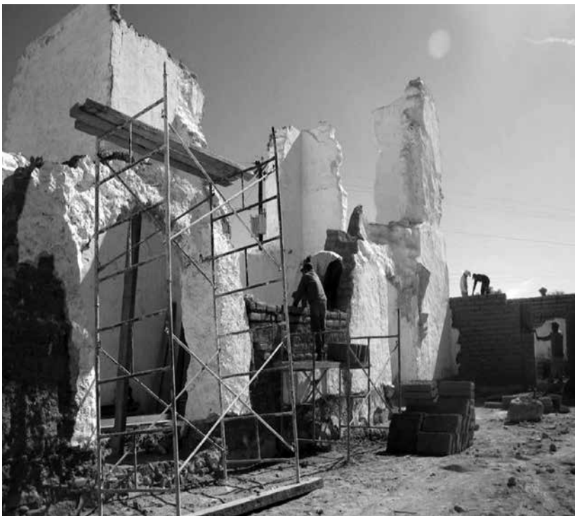
Figura 14. Consolidación de muros de adobe de 1 m de espesor. Fotografía de Alberto Ramírez Ramírez.
