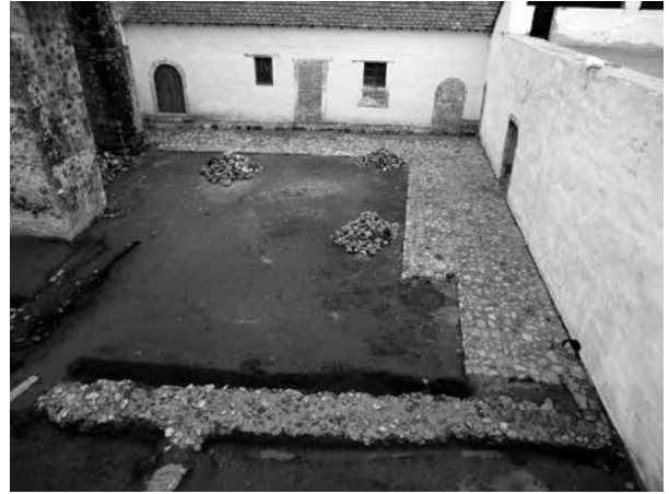
Figura 14. Cimientos de piedra de los corredores y claustro de Santo Domingo Hueyapan, definidos por medio de exploraciones arqueológicas. Fotografía de Mario Córdoba Tello.
