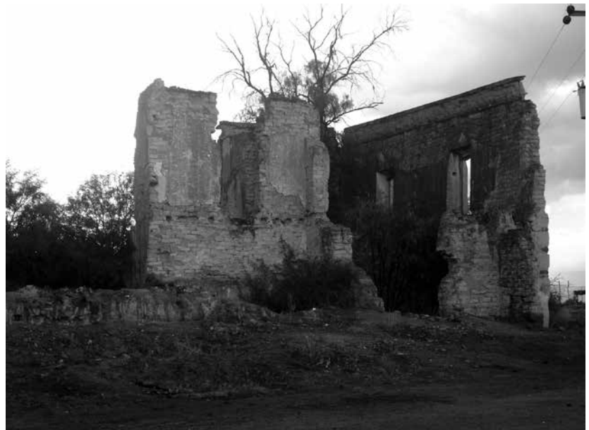
Figura 11. Ruina de la esquina sureste de la "casa grande". Fotografía de Alberto Ramírez Ramírez.
