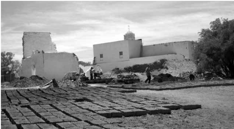
Figura 13. Fabricación de 25 000 adobes para la restauración. Fotografía de Alberto Ramírez Ramírez.
