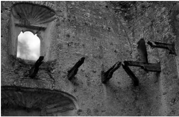
Figura 6. Vigas que sostenían el coro en la iglesia de Sabán, Quintana Roo.
