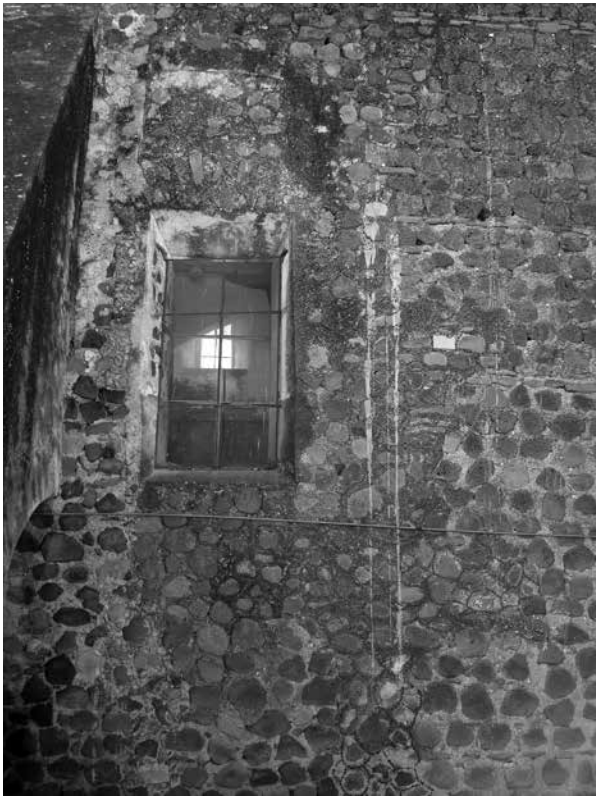
Figura 15. Sección del muro norte del templo de San Juan Bautista Tetela del Volcán, en el que se aprecia la sucesión de hiladas de piedra amarradas con el mortero de calarena de tezontle rojo y arcilla. Fotografía de Mario Córdova Tello.
