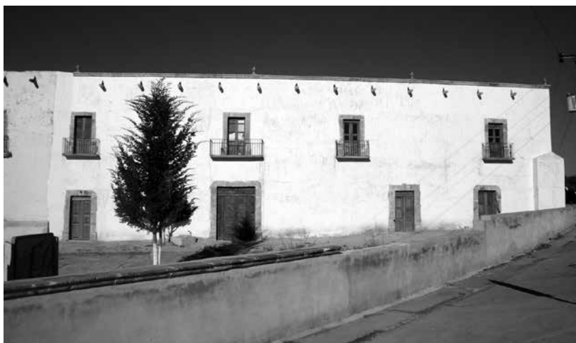
Figura 9. Vista de la "casa grande" restaurada con sus balcones y puertas asimétricas, características constructivas del siglo XVIII. Fotografía de Alberto Ramírez Ramírez.
