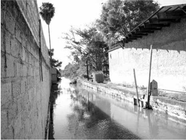
Figura 18. Zanja que alimentaba la turbina del molino de trigo (pared derecha). Fotografía de Laura Pacheco, marzo de 2012.
