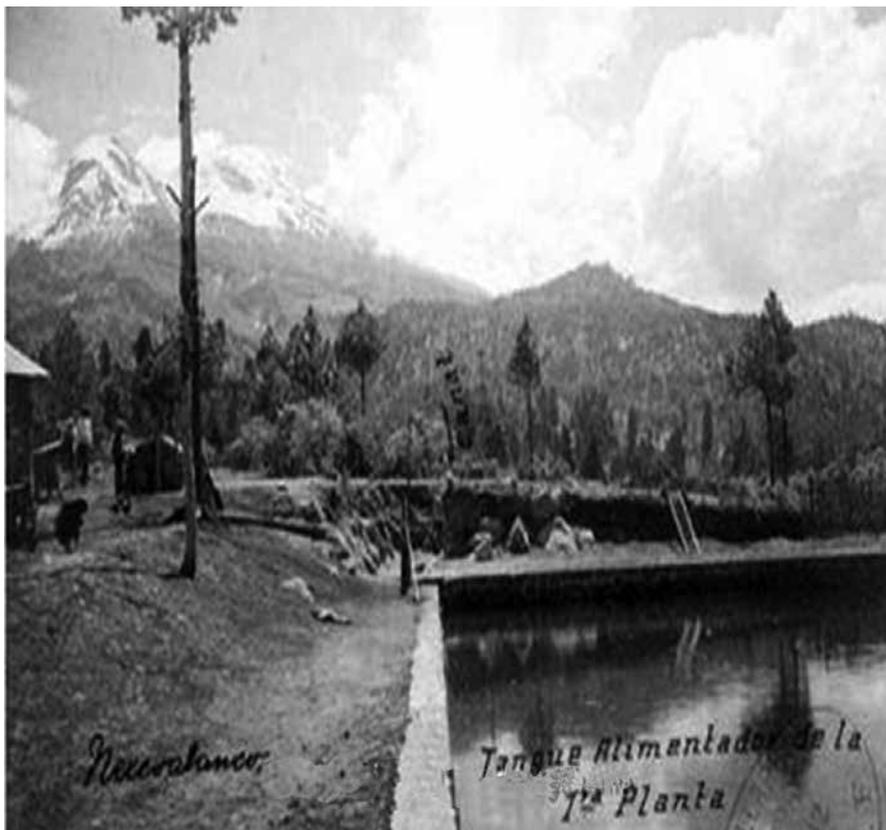
Figura 6. Tanques alimentadores para la producción de energía eléctrica. Archivo Histórico del Agua, Aprovechamientos superficiales, caja 260, exp. 6263. En esta imagen además de ser muy ilustrativo el uso del espacio en la construcción de amplios tanques de almacenamiento de agua, se muestra parte del desmonte que se ha dado al bosque.
