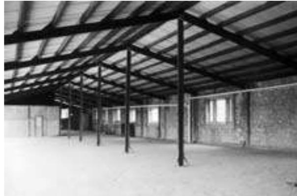
Interior planta alta, nave norte. Se observa la estructura con armadura de madera, columnas metálicas y techo a dos aguas de lámina de zinc. Fotografía: Carlos Segura Martínez, junio de 1999.
