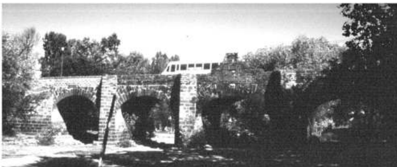
Figura 10. Autobús pasando sobre el puente. Foto: G. Bolla, 2004.
