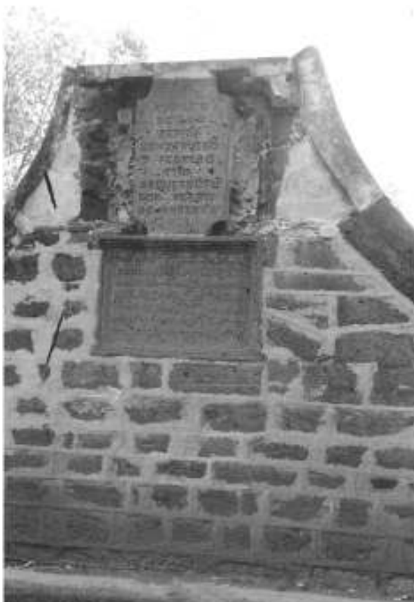
Figura 2. Cornisa en el muro sur del puente, con fechas de construcción. Foto: G. Bola, 2004.
