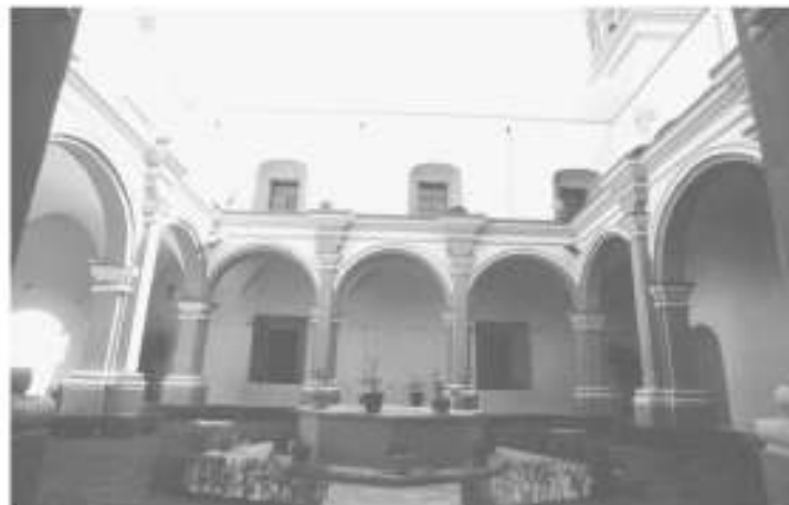
Figura 17. Fachada meridional del claustro del convento. Observese la existencia de corredores bajos únicamente.
