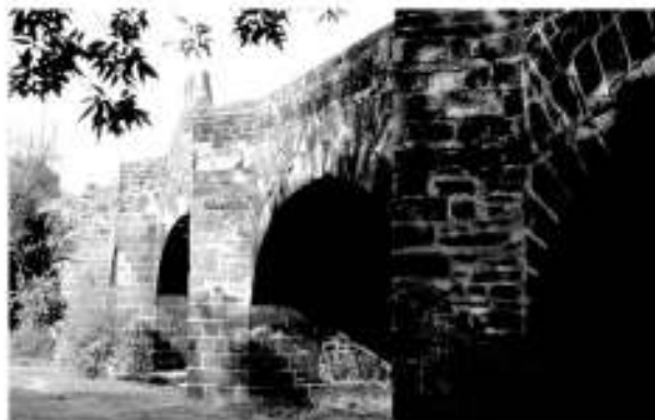
Figura 9. Vista del puente desde el sureste. Foto: G. Boís, 2004.
