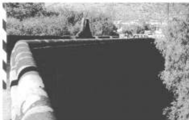
Figura 8. Muro barandal desde el lado nordeste. Foto: G. Boís, 2004.
