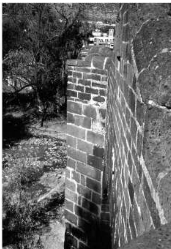
Figura 3. Contrafuerte en el lado sur. Foto: G. Bola, 2004.
