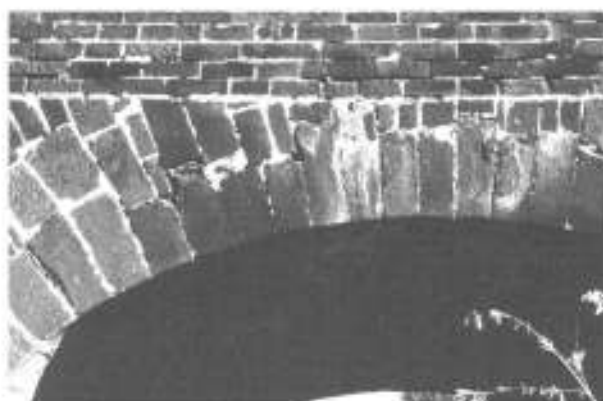
Figura 13. Detalle de las dovelas de un arco. Foto: G. Bois, 2004.
