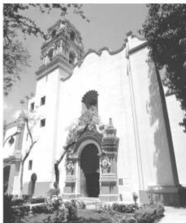
Figura 12. Fachada principal del templo que mira al poniente.
