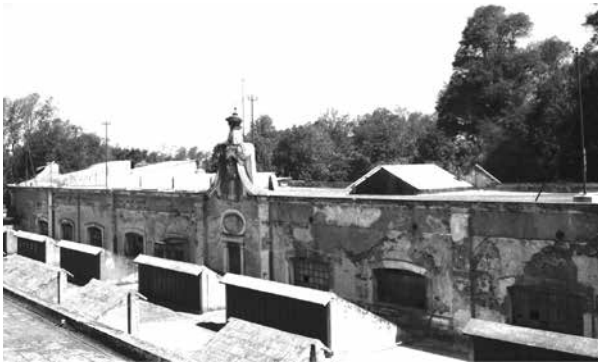
Figura 14. Vista actual de la antigua fachada principal de la fábrica La Constanca Mexicana. Foto de Juan Manuel Márquez Murad y Tatiana Cova Díaz.
