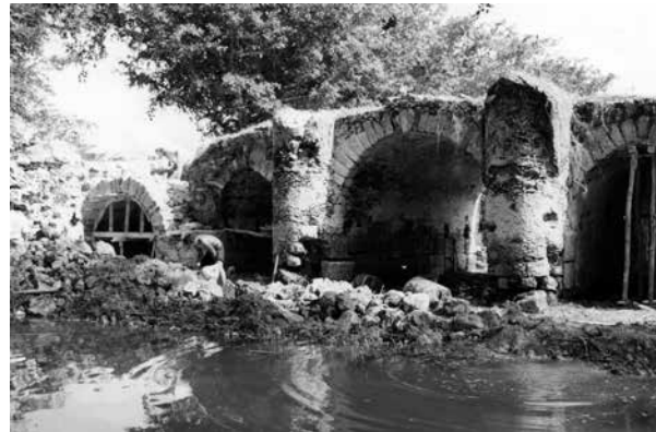
Figura 4. Costado oeste del puente durante las obras de restauración.
