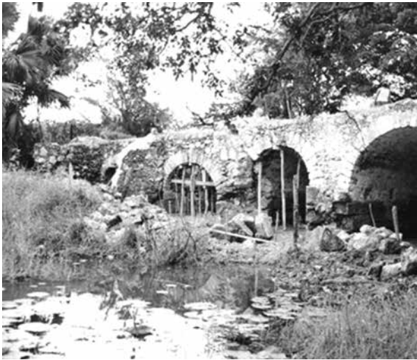
Figura 3. Lado este del puente durante los trabajos de restauración.
