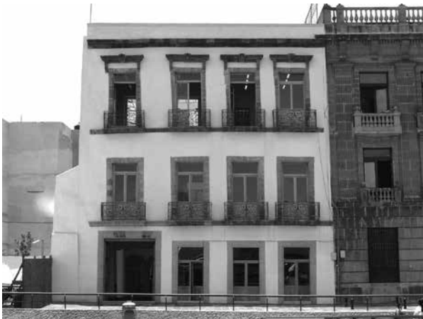
Figura 2. Fachada del inmueble localizado en la calle República de Argentina número 8.
