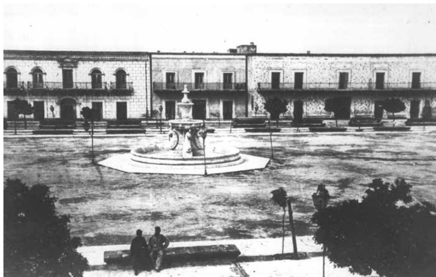
Figura 6. La Fuente de los Delfines. Detalle de la plaza de Zaragoza, 1866.
