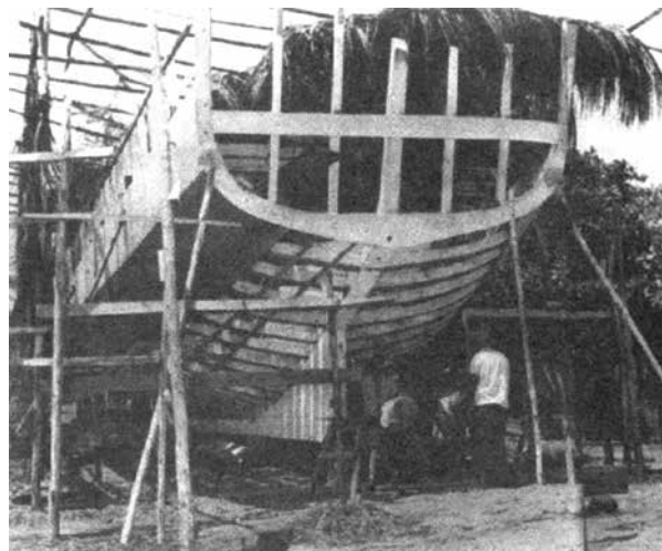
Figura 4. Maestros carpinteros del Carmen a la sombra del barco en construcción en el astillero y aserradero. Fotógrafo desconocido, en Efraín Caldera Noriega (comp.), Imágenes del ayer , Ciudad del Carmen, México, 2004.
