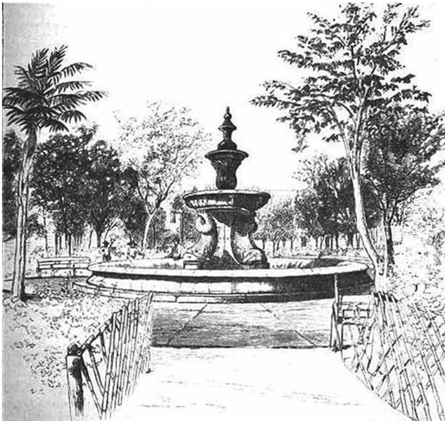
Figura 9. La Fuente de los Delfines en la plaza de Zaragoza, 1884.
