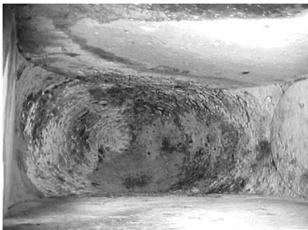
Figura 17. Detalle de aparejo circular en bóveda de escalera. Tixcaclutub, Yucatán. Foto de Arturo Román.
