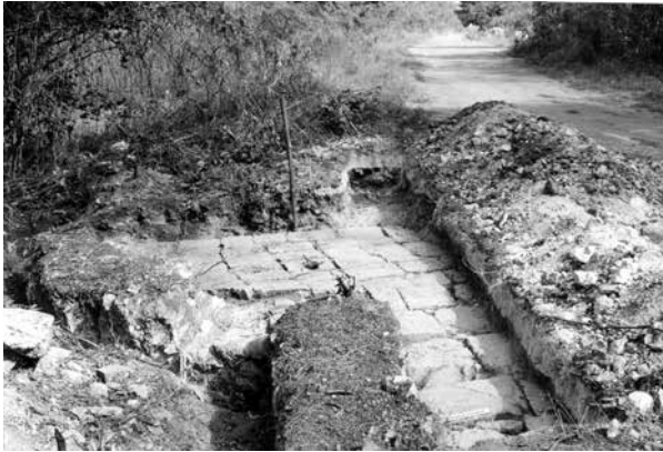
Figura 8. Sillares prehispánicos reutilizados como empedrado.
