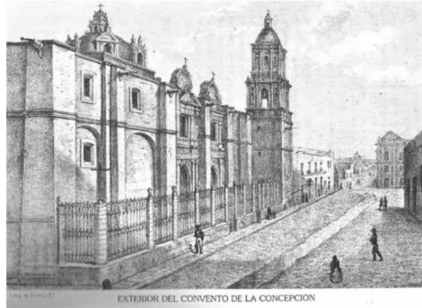
Figura 2. El convento de la Concepción y parte del edificio de las Bonitas. Litografía de Hesiquio Iriarte en Manuel Ramírez Aparicio, Los conventos suprimidos de México , México, Innovación, 1979.
