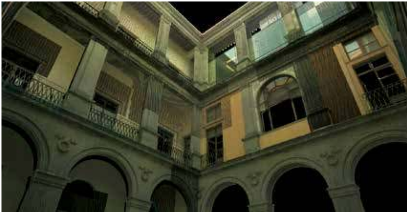
Figura 7. Fachadas en nube de puntos con fotografía del patio principal del edificio sede de la Coordinación Nacional de Monumentos Históricos, ciudad de México. 2008-2009.
