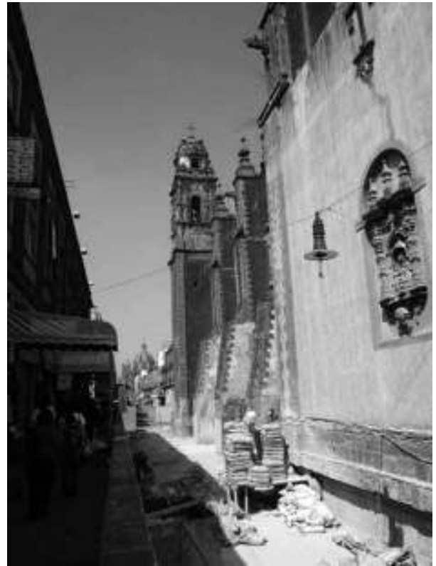
Figura 17. Obras en el antiguo atrio y calle del costado sur del templo. El muro visible corresponde a la fachada lateral. Calle de Emiliano Zapata. Fotografía de Pedro Paz Arellano, 25 de febrero de 2009.
