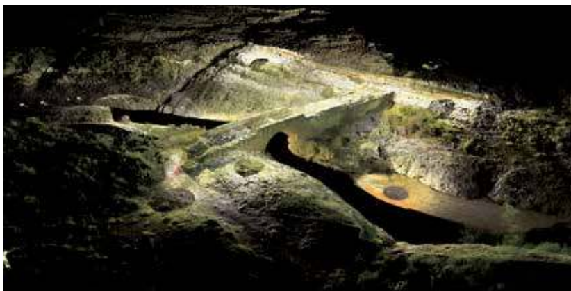
Figura 13. Perspectiva en nube de puntos con fotografía del puente de Tequixtepec, Oaxaca. 2011.
