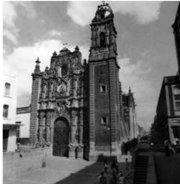
Figura 21. Fachada del templo de la Santísima liberada. Fotografía del arquitecto Agustín Salgado, 1982.
