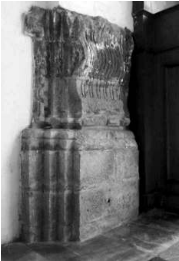
Figura 10. Pilastra con estrías ondulantes que se dejó como testigo en el muro de la epístola de la nave, en el tramo correspondiente al sotocoro. Fotografía de Martha Ghigliazza Solares, 5 de agosto de 2011.
