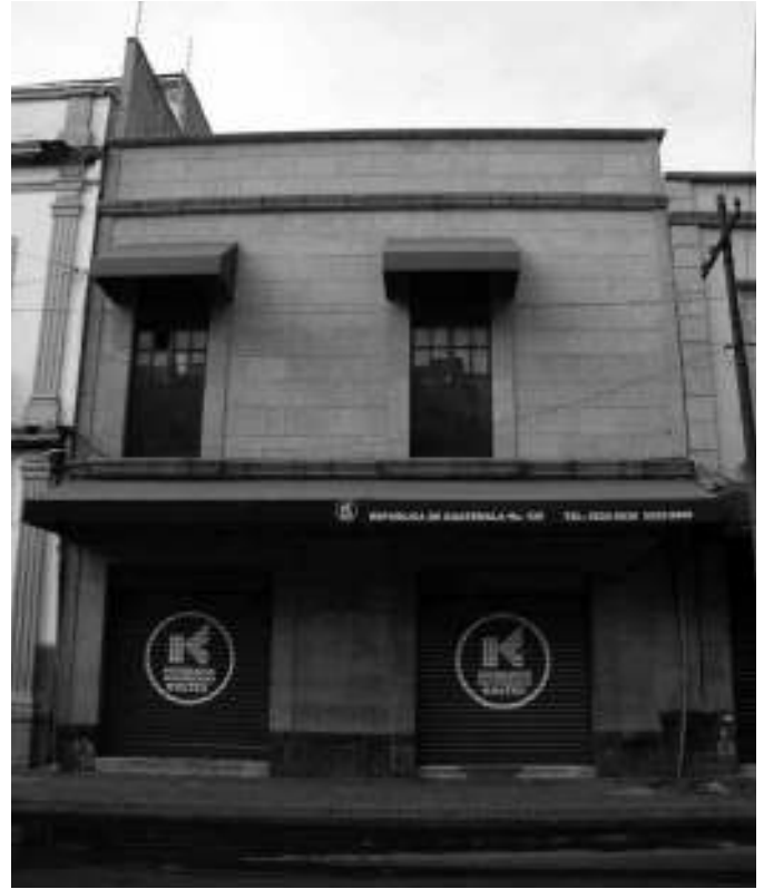
Figura 26. El inmueble número 5 actualmente, donde se observan los cambios. Fotografía de Ethel Herrera Moreno.
