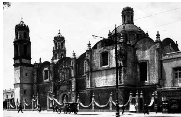
Figura 12. Antigua fotografía, probablemente de 1926, en la que se luce la recién construida barda realizada por el arquitecto Esteva; la demolición de la misma en una época en que el modernismo se imponía fue un error que pone al templo en riesgo; la reconstrucción de la misma parece ser una deuda que debería cobrarse, para reafirmar su condición de patrimonio nacional (foto del INAH).
