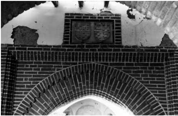
Figura 17. Portada del antiguo hospital de San Miguel de Zafra, Badajoz, en el que se conserva la pintura imitando una fábrica de ladrillo muy regular que cubre el aparejo original de ladrillo. Fotografía de Pilar Mogollón.
