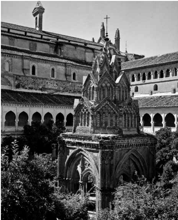
Figura 5. Fotografía del templete mudéjar central del claustro del Monasterio de Guadalupe (1935), tras la restauración efectuada en los años 1933 y 1934 por el arquitecto Luis Menéndez-Pidal. Fundación Instituto Amatlán de Arte Hispánico, Archivo Mas.
