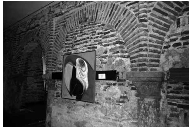
Figura 11. Antiguo edificio de la Aduana que ha sido adaptado a Museo de Arte Moderno en Cartagena de Indias, Colombia. Observamos que se ha seguido la generalizada práctica de hacer desaparecer el encalado, alterándose el principio estético con el que fue concebido. Fotografía de Pilar Mogollón.
