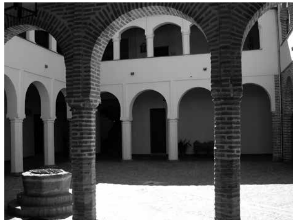
Figura 12. Patio del Complejo Cultural de la Merced de Llerena, Badajoz, inaugurado en 2003. En esta restauración se expone el debate entre la eliminación y la permanencia de los revestimientos. Fotografía de Pilar Mogollón.
