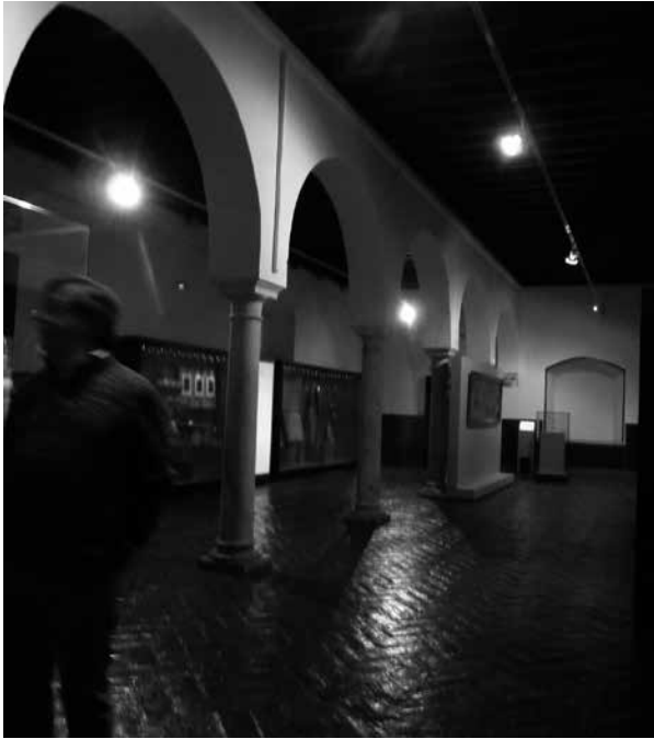
Figura 13. Sala baja de la antigua enfermería del monasterio de Nuestra Señora del Valle, convertido desde enero de 2007 en el Museo Santa Clara de Zafra, Badajoz. En esta sala expositiva comprobamos que el arquitecto opta por mantener la sinceridad del estilo, la autenticidad y el respeto al contexto cultural del patrimonio mudéjar al conservar los encalados en las arquerías. Fotografía de Pilar Mogollón.
