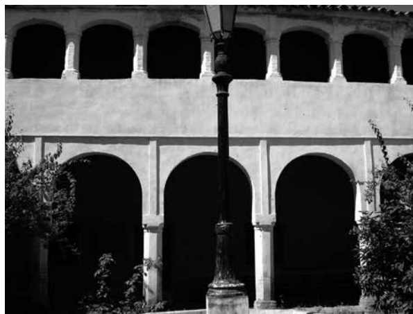
Figura 16. Patio de la antigua Casa Prioral, luego Tribunal de la Inquisición de Llerena, Badajoz, único ejemplo localizado en Extremadura en que se utilizó un mortero mixto de cal aérea y yeso. Fotografía tomada antes de la última restauración. Fotografía de Pilar Mogollón.
