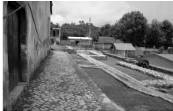
Figura 10. La banqueta que sustenta al claustro tiene una altura de 40 centímetros. De cierta forma, la altura de la banqueta aislaba al claustro del área de tanques, evitando humedad al interior de las dependencias del claustro bajo. La banqueta se elaboró con canto rodado, unido con argamasa de arcilla y agua. El arreglo de la piedra fue a manera de rombos.
