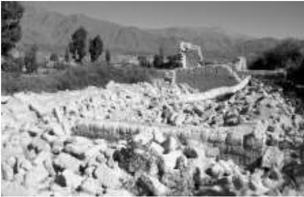
Figura 20. Escombros de la misma construcción a finales de 2012.
