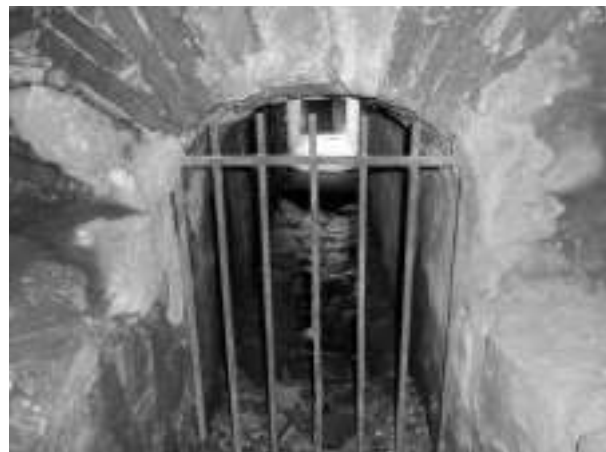
Figura 13. Entrada del canal a la cloaca. Fotografía de Virginia Guzmán, 2013.
