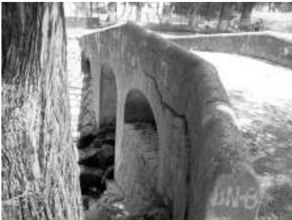
Figura 1. Puente del Molino de San Cayetano, en Capulhuac, Estado de México. Finales del siglo XVIII. Fotografía de Guillermo Boils, 19 de julio de 2008.
