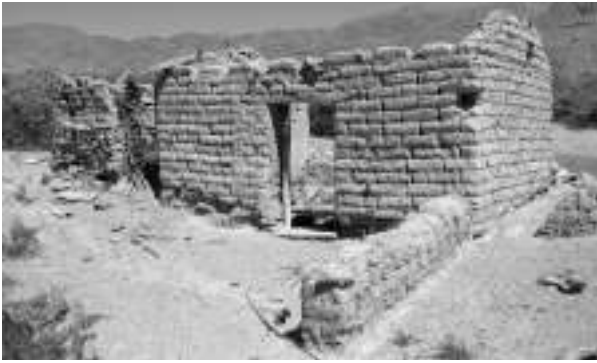
Figura 4. Construcción vernácula de adobe en la Quebrada de Potrero.
