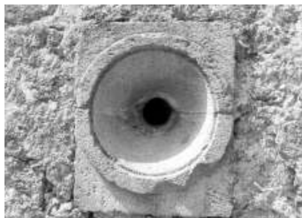
Figura 14. Respiradero exterior de la cloaca. Fotografía de Virginia Guzmán, 2013.
