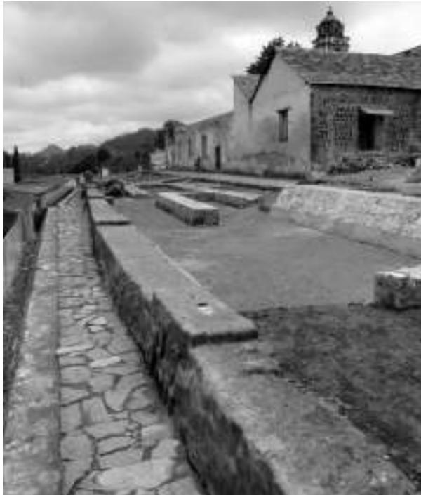
Figura 11. En primer plano se ven el canaleta y el aljibe a los que llegaba el agua de la barranca Tepetlayecac. Del aljibe pasaba a los tanques del puente, mientras que el canaleta, con varias compuertas, dejaba pasar el agua hacia la huerta, en el nivel subsiguiente.
