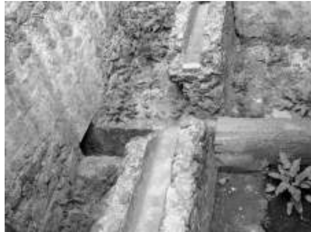
Figura 12. Debajo de lo que fue alguna dependencia del convento se aprecia en la parte superior el canal que conducía el agua, y debajo de éste, cubierto por bóveda, el de desagüe que pasaba por debajo de los sanitarios del convento. Fotografía de Virginia Guzmán, 2013.
