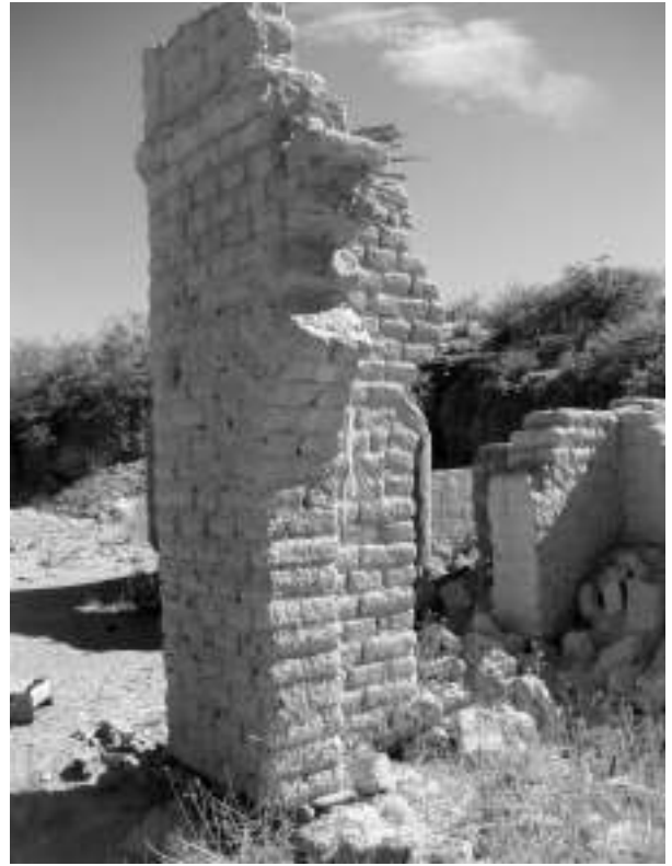
Figura 21. Detalle de la única sección de un arco que se conserva en el sitio.
