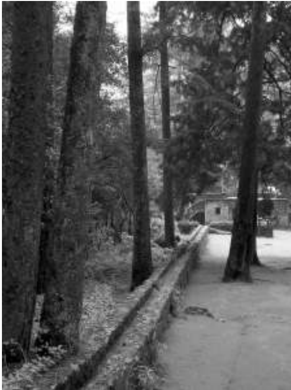
Figura 3. Canal de abastecimiento de la ermita de San Juan. Fotografía de Virginia Guzmán, 2013.
