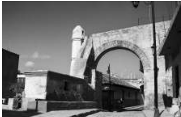
Figura 3. Acueducto y pila de Carranza en la actualidad. Fotografía de Miguel Espinosa.
