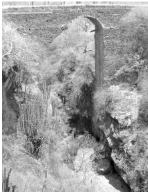
Figura 3. Vista desde el sudoeste del puente y la barranca de Tecajec, Morelos. Al fondo, arcadas de un acueducto del siglo XIX. Fotografía de Guillermo Boils, 12 de enero de 2012.
