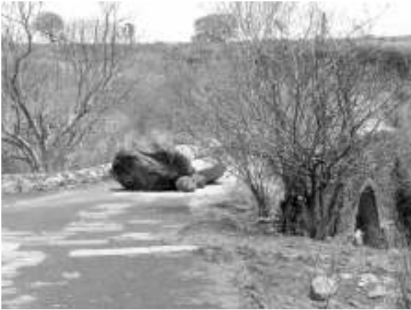
Figura 5. Rocas bloqueando el paso en el puente de Tecajec. Fotografía de Guillermo Boils, enero de 2012.
