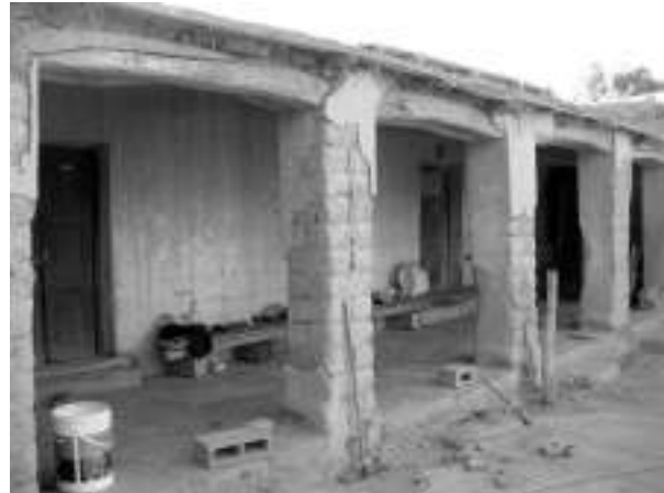
Figura 6. Ejemplo de construcción de adobe con pórtico en la Finca de Potrero. Nótese los dinteles de madera de algarrobo.
