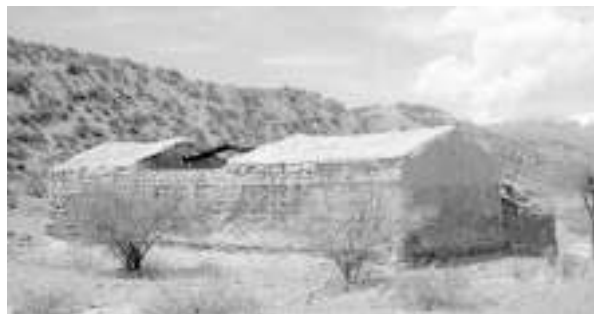
Figura 18. Vivienda de adobe abandonada en el Valle Calchaquí.
