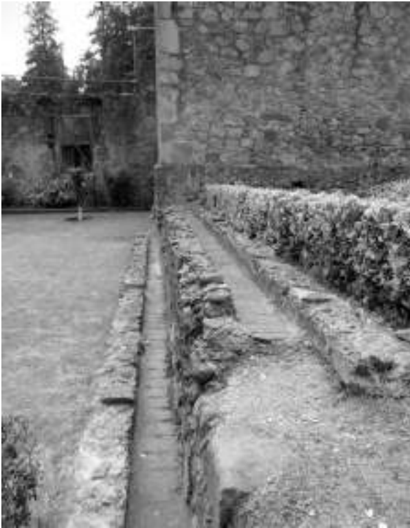
Figura 11. En la imagen se puede apreciar el canal de la parte alta que conducía el agua; el de la parte baja la desagaba y vertía a la barranca. Fotografía de Virginia Guzmán, 2013.
