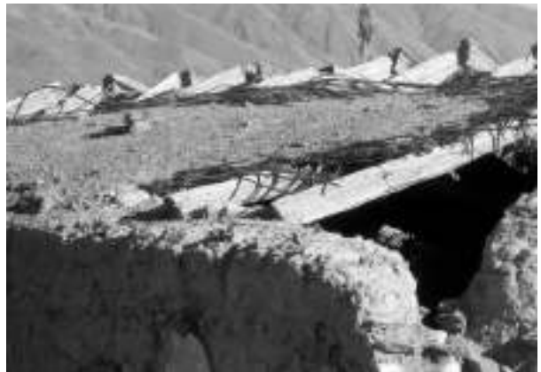
Figura 10. Detalle de una cubierta con la capa de arcilla.
