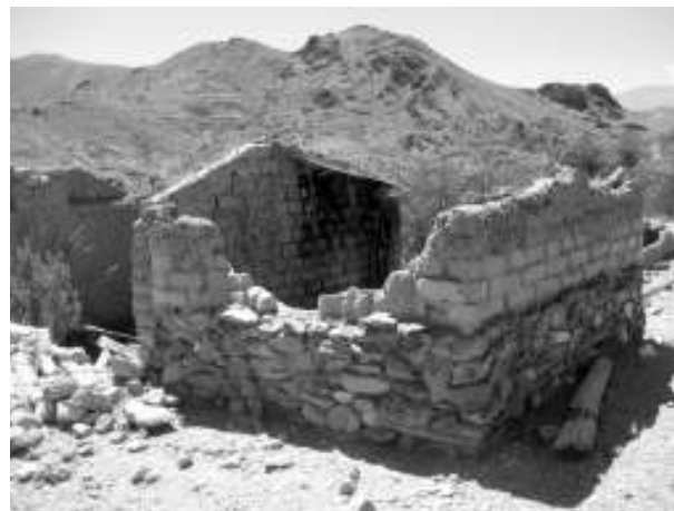
Figura 7. Construcción en la Quebrada de Potrero con rodapié de piedra y alzados de adobe.
