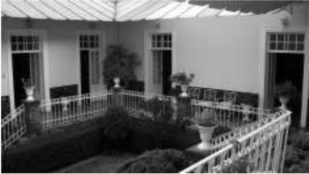
Figura 4. El ancho de los predios solía permitir la inserción de patios. La forma de "C" con el lado abierto al sur, propiciaba más soleamiento en invierno. Esta solución fructificó en las primeras décadas del siglo xx, de cuando data este ejemplo. Fotografía de René L. Sánchez.
