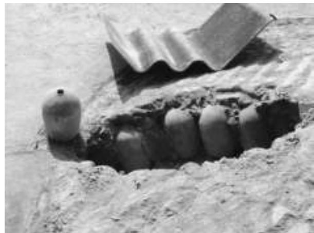
Figura 12. Detalle de sustitución de elementos constructivos en bóveda del inmueble, 2004. Archivo de la SMH-Centro INAH Colima, exp. Templo del Sagrado Corazón, Sismo 2003.
