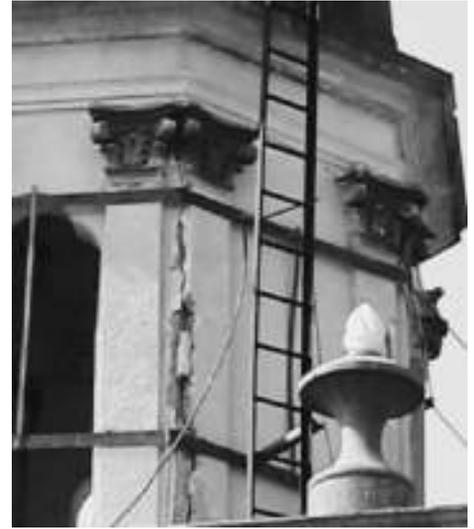
Figura 13. Identificación de intervenciones anteriores con grapas y elementos metálicos — como tensores y crucetas — en muros de carga del inmueble, 2004. Archivo de la SMH-Centro INAH Colima, exp. Templo del Sagrado Corazón, Sismo 2003.
