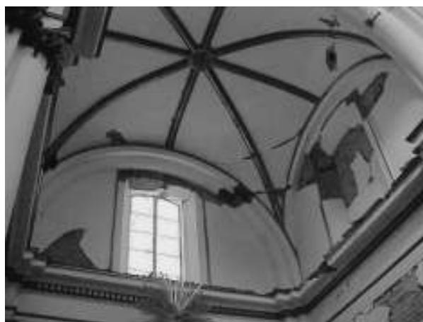
Figura 4. Detalle de daños provocados por el sismo en cubiertas y muros del inmueble, 2003. Archivo de la SMH-Centro INAH Colima, exp. Templo del Sagrado Corazón, Sismo 2003.
