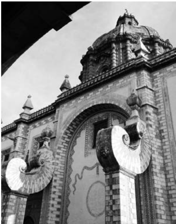
Figura 14. Arco de descarga. Fotografía de Mina Ramírez Montes.
