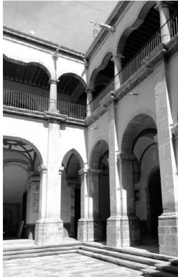
Figura 51. Arcos erróneos en el lado norte del claustro. Abajo arco ojival, arriba arco rebajado. Fotografía de Mina Ramírez Montes.
