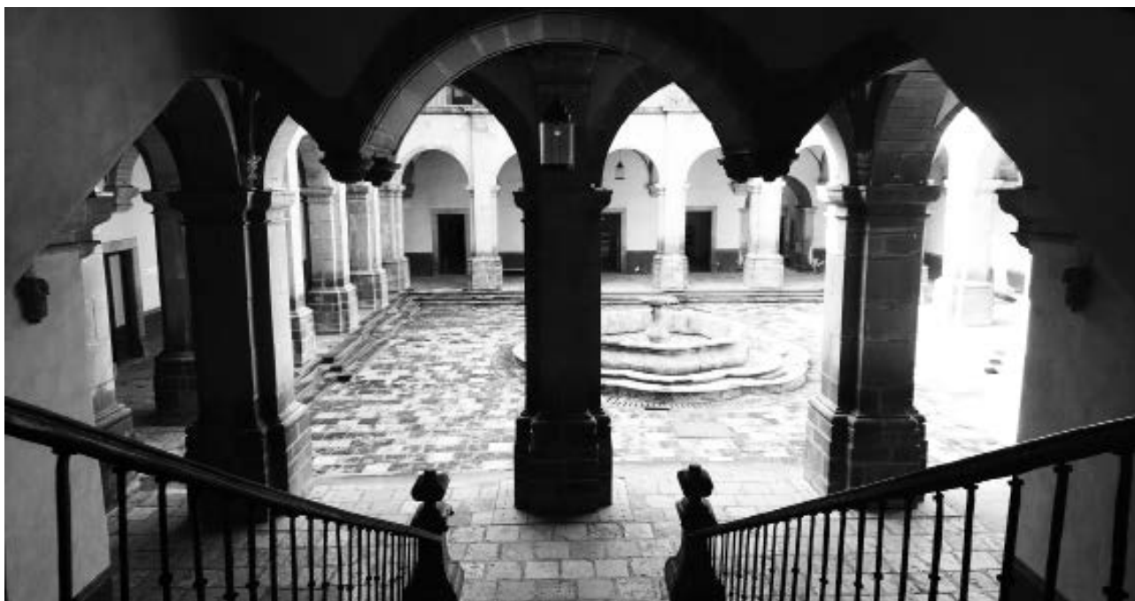
Figura 46. Arcos volados hacia el claustro. Fotografía de Mina Ramírez Montes.
