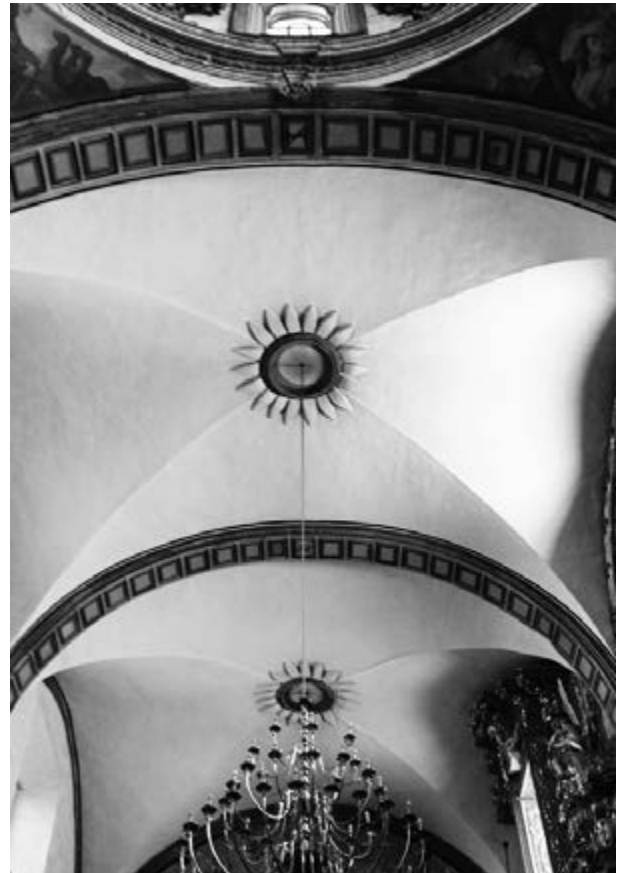
Figura 21. Bóvedas de la nave del templo. Fotografía de Mina Ramírez Montes.
