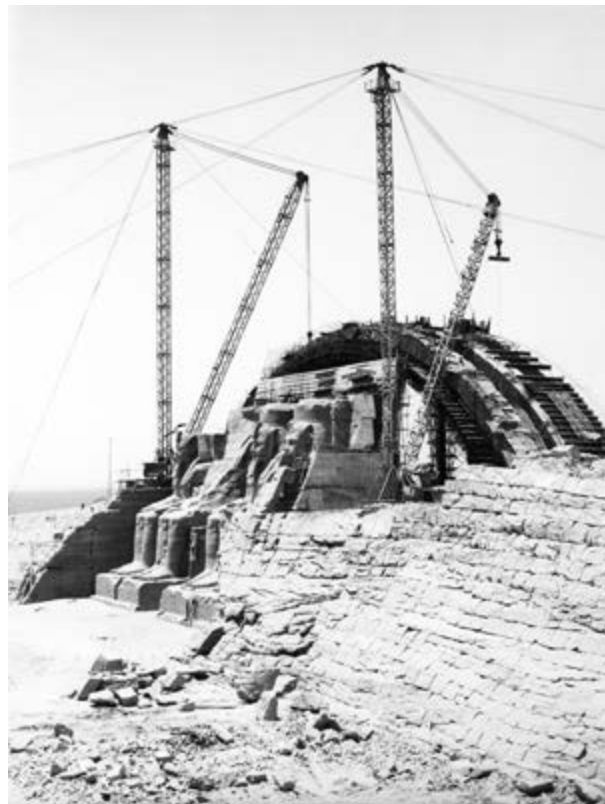
Figura 9. Construcción de bóveda hueca para alojar y reensamblar los templos de Abu Simbel. Fotografía de la página Peignoirprod recuperada de: < http://peignoirprod.com/Nouveausite2018/wp-content/uploads/2019/01/Work_in_progress_of_the_re-erection_of_the_Great_Temple_on_its_new_site-unesco-1966.jpg >.
