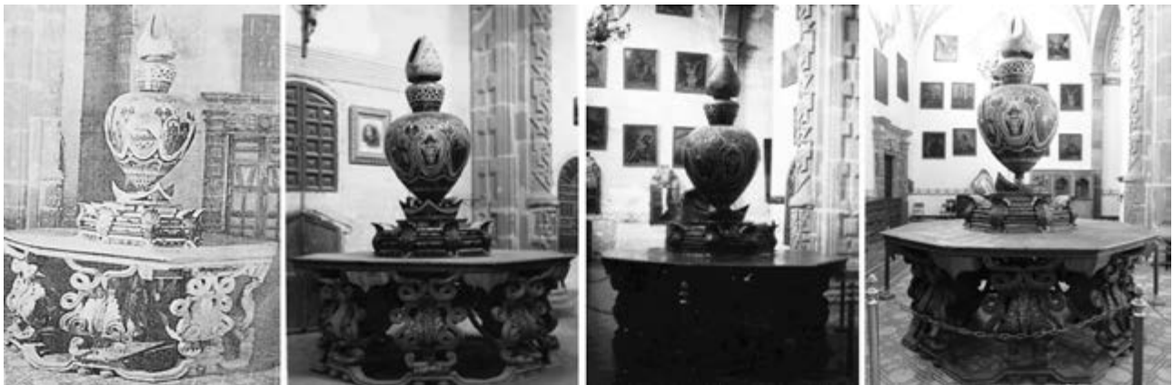
Figura 31. Comparativa fotográfica en la que se comprueban las modificaciones que ha tenido la mesa. Desconocemos las fechas exactas de las imágenes antiguas, pero la cronología está basada en las condiciones que presenta la mesa, en su orientación y en la aparición de los postes y cadenas que la aíslan. En la primera toma vemos la mesa con faltantes en los roleos de las patas, los cajones de los vértices incompletos, la falta de cajones entre los espacios superiores de las patas y una inclinación pronunciada en la obra, además, los picos del bonete coinciden con los extremos de la cajonera cruciforme, al igual que la cara principal del gran corazón, y la mitra está de perfil hacia la cara principal. La obra se ubica al centro de la sacristía y su cara principal ve hacia la entrada de la antesacristía. En la segunda fotografía la mesa tiene mejor aspecto; las patas están completas, los cajones de los vértices cuentan con sus tapas, la inclinación ya no es tan pronunciada, pero los picos del bonete y la cara principal se alinean a los ángulos de la cajonera cruciforme, además, la mitra está ligeramente inclinada a la cara principal y, aunque la mesa sigue estando en medio del lugar, la cara principal se dirige hacia el muro horizontal donde se dispone una gran cajonera. Se puede apreciar que los muros de la sacristía tenían sillares pintados. En la tercera fotografía ya aparecen los postes y cadenas que la protegen, los picos del bonete y la cara principal siguen coincidiendo con los ángulos de la cajonera con forma de cruz, pero la mitra ve hacia la cara principal. La obra sigue ocupando el centro del secretarium , aunque, de nueva cuenta, la cara principal se dirige a la antesacristía. En la cuarta fotografía, capturada en octubre de 2015, los picos del bonete hacen eje con los ángulos de la cajonera cruciforme, pero la cara principal del corazón ahora se alinea con el extremo de la cruz y la mitra vuelve a mostrarse de perfil hacia la cara principal. Llama la atención que el gran corazón se alza a una mayor altura en comparación a las otras imágenes. Hoy en día la mesa dirige su vista como en la primera y la tercera toma. La primera fotografía aparece en Juan José Rodríguez Chávez, Crónicas de Salamanca (Salamanca, Gto., Casa de la Cultura, 1994, p. 200); la segunda proviene del archivo digital: Apuntes históricos de la ciudad de Salamanca, Guanajuato , Colección FotoSal.limg296, del Archivo Histórico de Salamanca; la tercera aparece en Guillermina Gutiérrez Lara, Sitios y monumentos del INAH [CD-ROM] , imagen 0010020B; y la cuarta es fotografía de Marte González Ramírez, tomada el 14 de octubre de 2015.
