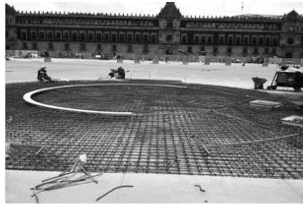
Figura 25. Instalación de placas alusivas al "zócalo" sobre el emparrillado. Fotografía de Alejandro Meraz Moreno, Gonzalo Emilio Díaz Pérez, Rubén Arroyo Ángeles y Ricardo Castellanos Dounce, op. cit.
