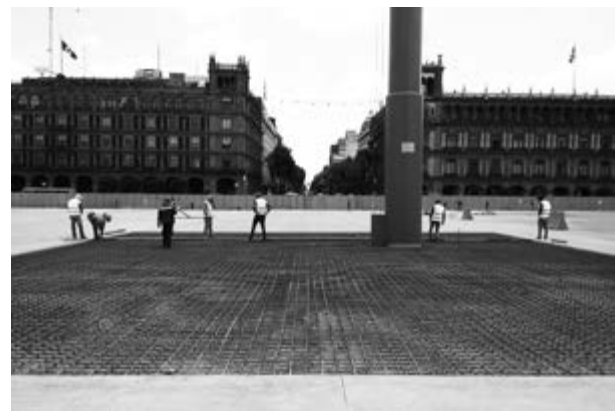
Figura 24. Emparrillado doble de varillas de acero instalado sobre los vestigios arqueológicos. Fotografía de Alejandro Meraz Moreno, Gonzalo Emilio Díaz Pérez, Rubén Arroyo Ángeles y Ricardo Castellanos Dounce, op. cit.
