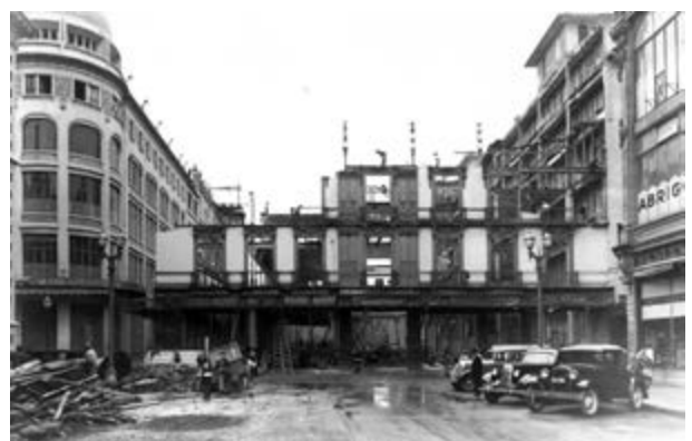
Figura 12. Perspectiva que muestra los trabajos de demolición de lo que fue el templo y convento de San Bernardo para el proyecto de apertura de la avenida 20 de Noviembre, dando paso a la fachada principal de la tienda departamental El Puerto de Liverpool, y su eterno compañero, el Palacio de Hierro, separados por la angosta callejuela de la Diputación. Colección de Miguel Ángel Bernabé Huerta.
