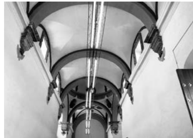
Figura 7. Nave con detalle de los arcos, bóvedas, lucarnas y pinjantes. Fotografía de Jesús Joel Peña Espinosa.
