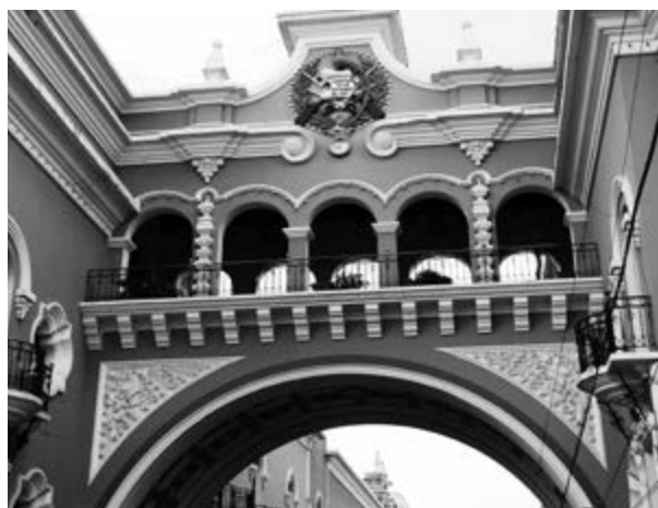
Figura 30. Fachada posterior del pasadizo del antiguo edificio de Correos y Telégrafos, hoy espacio cultural, Guatemala, 2019. Fotografía de Aracely Esquivel Vásquez, Miria Esquivel Vásquez y Marcela Dávila Esquivel.
