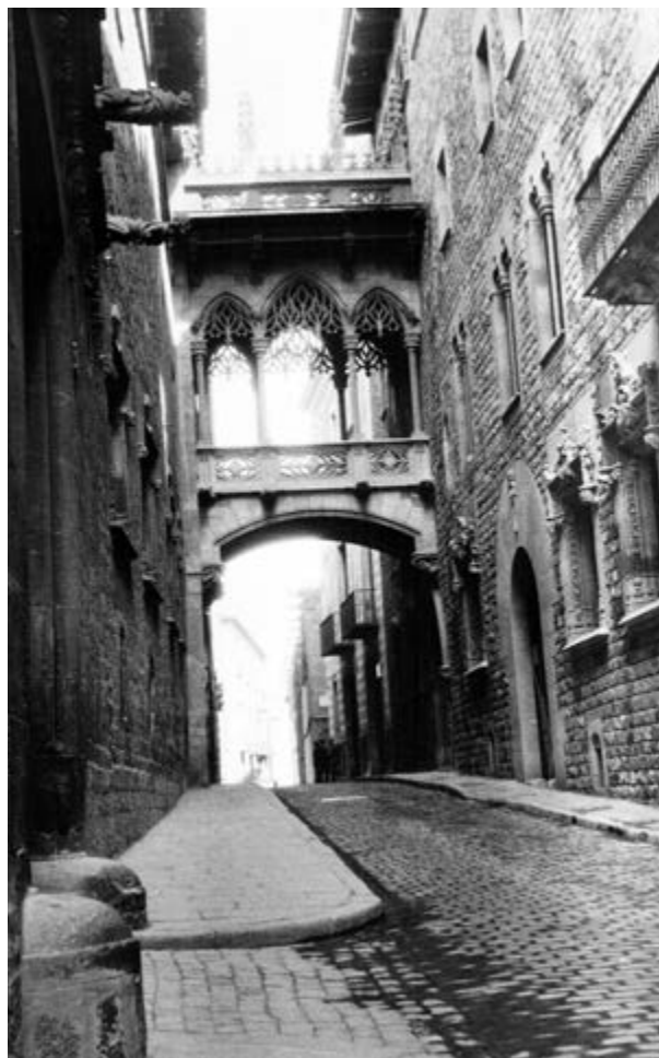
Figura 25. Puente de la calle del Obispo, barrio gótico, Barcelona, 1929-1930. Colección de Esther G. Domínguez Fernández.
