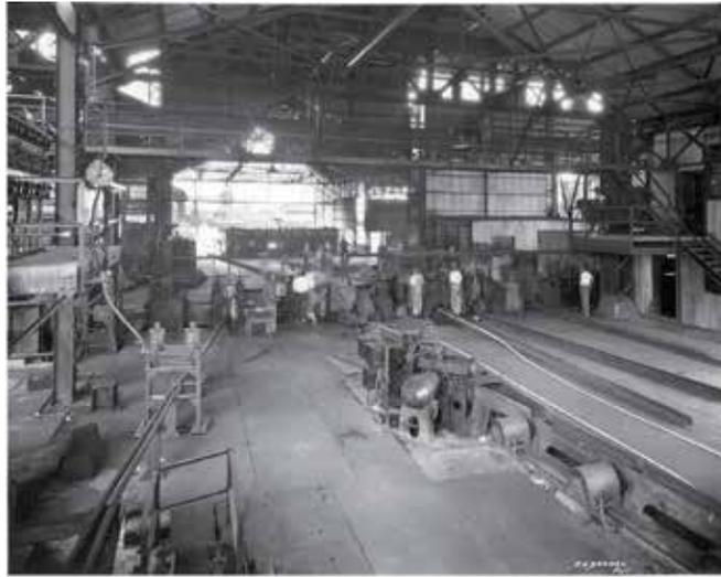
Figura 11. Obreros producen varilla corrugada con los molinos de laminación de 11", ca. 1945. Eugenio Espino Barros, Monterrey, N.L., México. D.R. © 42660 Fototeca Nuevo León-Conarte, Fondo: Fundidora.
