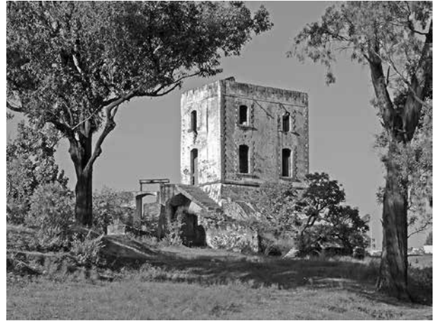
Figura 20. Vista de la obra de toma y la caseta de la planta Carmela. Fotografía de Luis Antonio Ibáñez González (2014).
