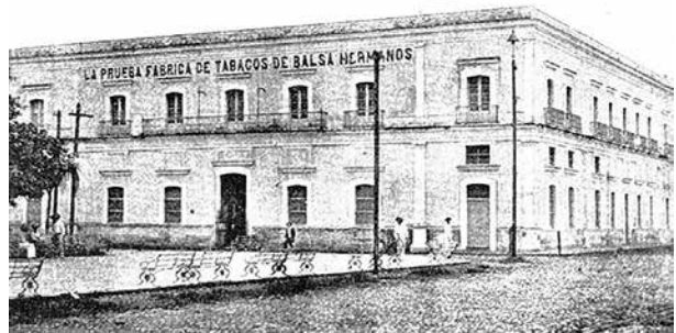
Figura 15. Fachada de 1900 de las calles Miguel Hidalgo y Miguel Lerdo. Foto del libro Puerto de Veracruz: Imágenes de su historia , México, Gobierno del Estado de Veracruz, 1992.
