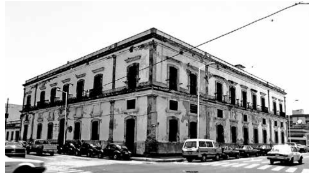
Figura 21. Imagen de las fachadas de las calles Miguel Hidalgo y Miguel Lerdo, tomada en 2006, antes de iniciar la obra de restauración. Expediente Técnico, Sección de Monumentos Históricos, Centro INAH Veracruz.
