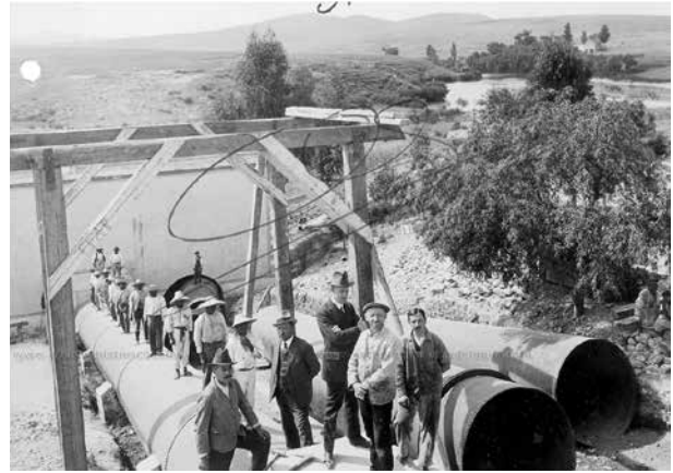
Figura 12. Obras efectuadas entre 1921 y 1922 para instalar la tubería de presión para el segundo grupo eléctrico y su turbina "Luisa". AHA, AS, c. 4211, exp. 56704, f. 284.
