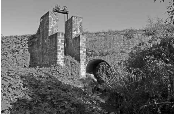
Figura 19. Aliviadero y bóveda de cañón corrido del puente Asunción. Fotografía de Luis Antonio Ibáñez González (2014).
