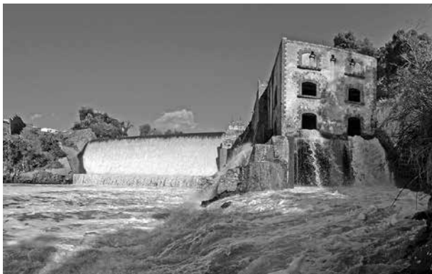
Figura 16. Vista frontal de la planta hidroeléctrica Carmelita. Fotografía de Luis Antonio Ibáñez González (2014).
