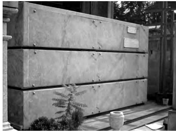
Figura 17. Construcción vertical para gavetas y nichos.
