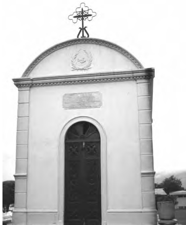
Figura 5. Tumba-capilla de la familia de don Bernardino de Peralta y Alvarado. Construcción de tipo neoclásico, con fachada simétrica y acceso a cripta por dentro. Material: ladrillo con repello de concreto. En la puerta de acceso aparecen los ángeles solamente representados por la cabeza y las alas en un círculo. Fotografía: Guillermo Brenes-Tencio.
