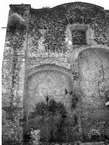
Figura 1. Exterior del muro sur del templo de San Lorenzo.
