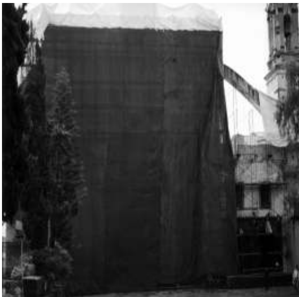
Figura 6. Trabajos de restauración en la fachada principal y capilla de indios del antiguo convento de San Bernardino de Siena. Fotografía de Araceli Peralta F., 2005
