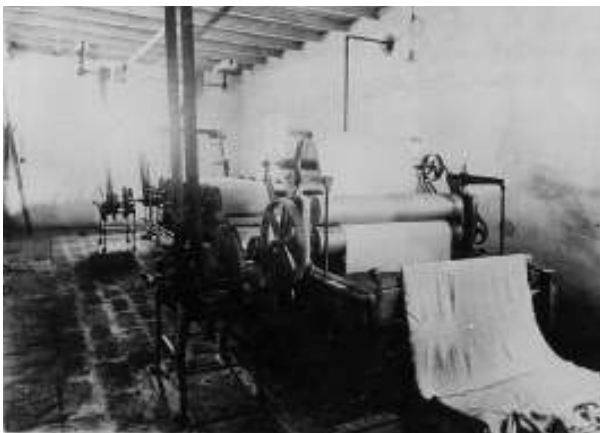
Figura. 6 Máquina foulardeuse de acabado. Fuente: Compañía de San Ildefonso, S.A., México, A. Briquet, 1899, s/f.
