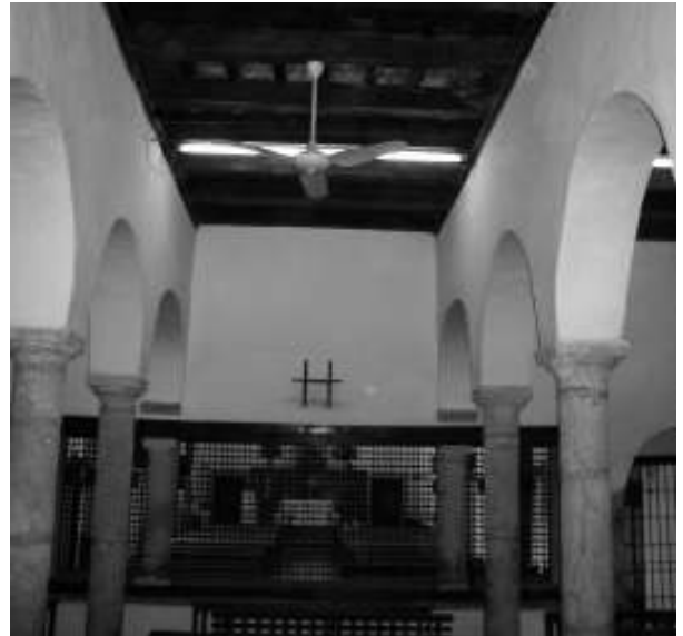
Figura 7. Vista interior del coro bajo en el que se aprecia la reja que lo separaba del resto del templo. Fotografía del autor, 2006.
