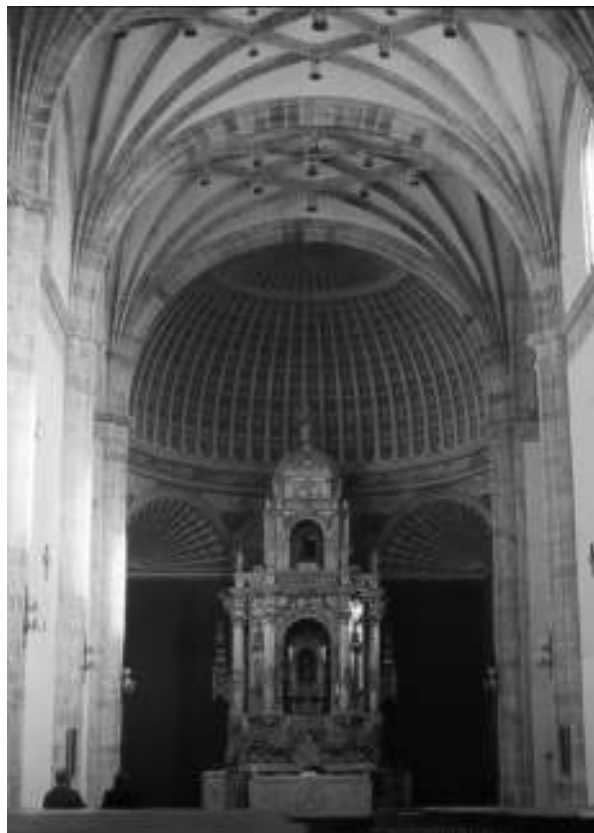
Figura 7. Bóveda avenerada de la iglesia del monasterio de las RR. MM. Bernardas, Salamanca.
