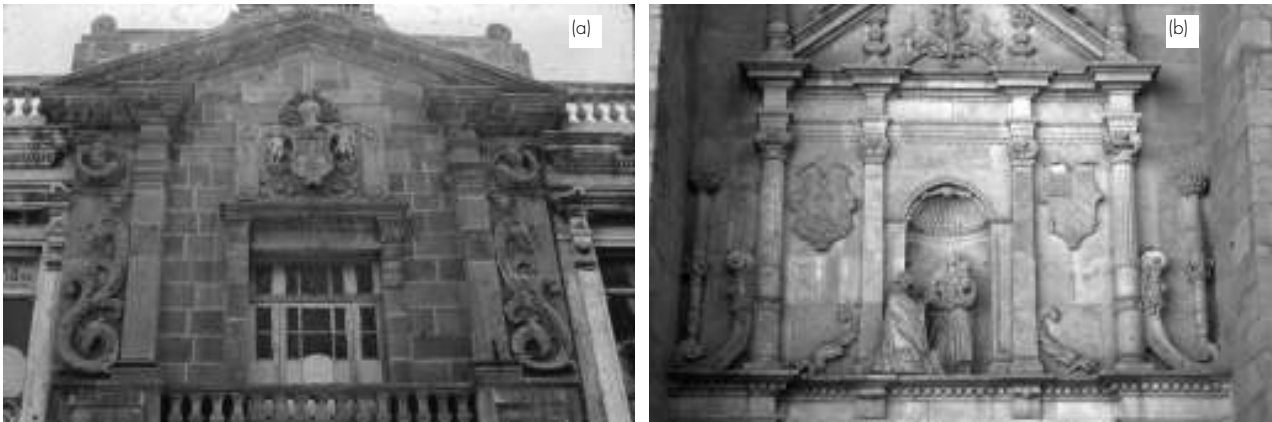
Figura 2. Tornapuntas de la fachada de (a) Alhóndiga de Puebla, y (b) Monasterio de las RR. MM. Bernardas, Salamanca. Fotografía del autor.
