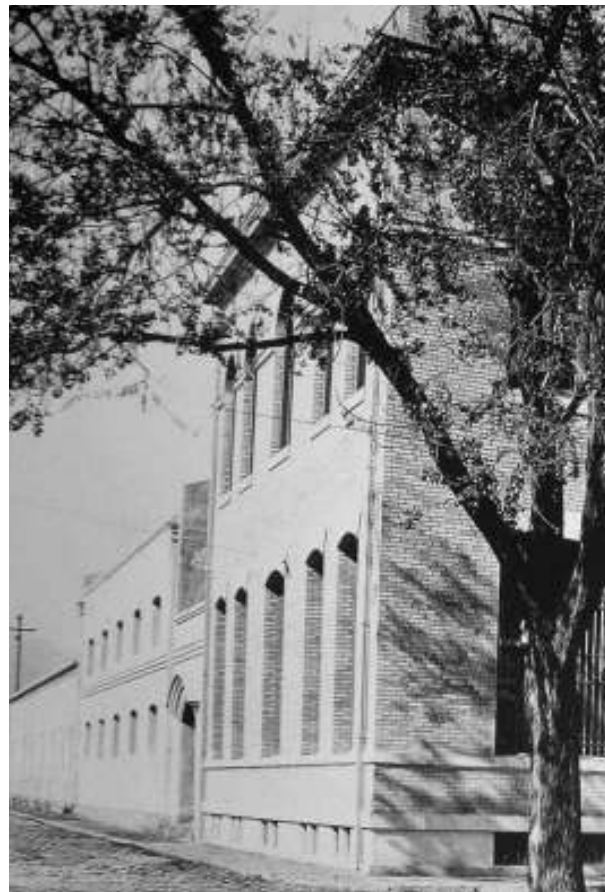
Figura 11. Fachada sur, ca. 1905.
