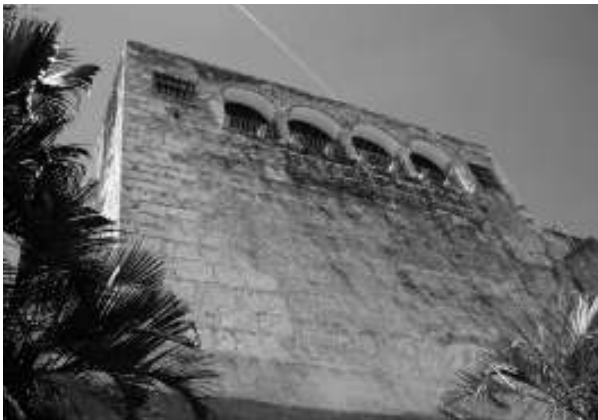
Figura 3. Vista del mirador, mismo que se encuentra sobre el ábside del templo. Fotografía del autor, 2006.
