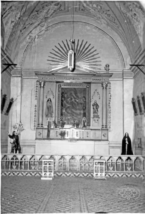
Figura 11. Interior de la capilla del Señor de los Trabajos, CNMH-AHPJE-Templo de Santiago Tejupan, Oaxaca, México, fotografía 002, ca. 1961.
