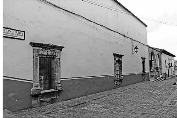
Figura 8. Acceso al recinto, actualmente Casa de los Once Patios, desde la calle Lerín. Foto de María Lizbeth Aguilera Garibay, 2021.
