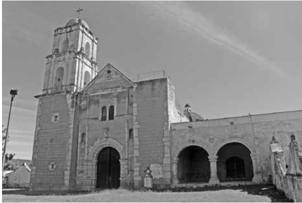
Figura 1. Fachada principal del ex convento de Santiago Tejupan. Fotografía de Yunuen Maldonado, 2019.
