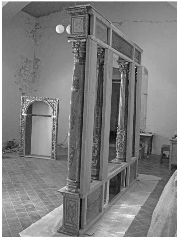
Figura 14. Vista posterior del retablo en la que se observa la recuperación del sistema estructural de la época. Archivo Luis Huidobro, 2007.
