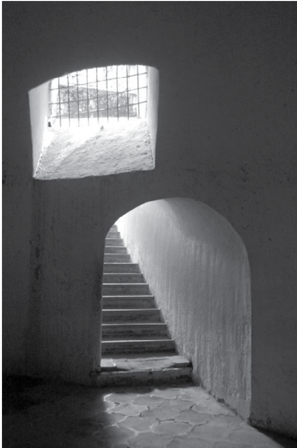
Figura 13. Cisterna de la torre. Se observa la escalera de acceso a la cisterna, así como la ventana por la que entraba el agua de lluvia. Fotografía de Loren Lemus.
