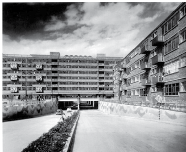
Figura 12. Paso a desnivel de la calle Orizaba del CUPJ; aquí se aprecian, al fondo, los túneles vehiculares que servían como soporte a la estructura de los edificios. Mario Pani Darqui, Los multifamiliares de pensiones , México, Arquitectura, 1952, p.87.
