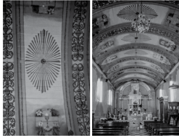
Figura 10. Bóveda de madera del templo de Santa Ana, Chapitiro, elaborada con cerchones y tablas de pino, decorada con cenefas y alegorías bíblicas. Fotografías del Archivo Torres Salomao.
