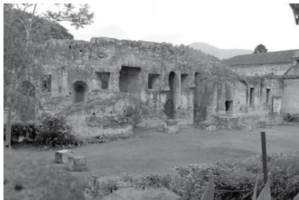
Figura 3. Patio del claustro viejo. Se observan posibles restos de pilares del Niñado, así como la caja de la escalera que accedía a la parte superior de la torre circular. También se pueden ver los aliviaderos con bóveda de horno. Fotografía de Loren Lemus.
