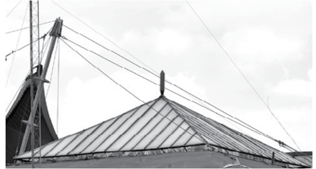
Figura 12. Exterior de la cubierta de la escalera principal del Palacio de Minería. Fotografía de Héctor Pineda, 2014.
