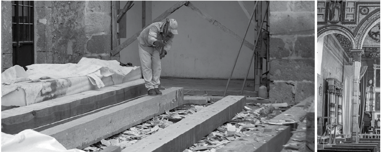
Figura 4. Uso de las herramientas. Izquierda: escuadría de grandes vigas, realizada con el hacha por los angareros. Derecha: detallado de un pilar con el hachazuela. Fotografías del Archivo Torres Salomao.
