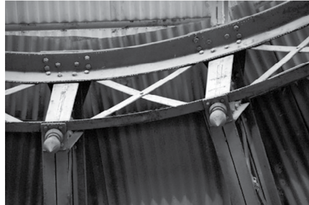
Figura 15. Detalle de los pomos que afianzan las vigas. Fotografía de Roberta Vassallo.
