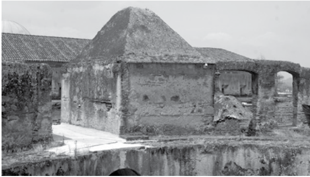
Figura 6. Segundo piso de la enfermería, con su cubierta a cuatro aguas. A su derecha se observan dos arcos escarzanos bajo los que circulan las cañerías que van hacia la cocina y la sauna del sanatorio. A su izquierda se pueden ver los arranques de los arcos que cosían la enfermería con el aljibe 11. Fotografía de Alberto Garín.
