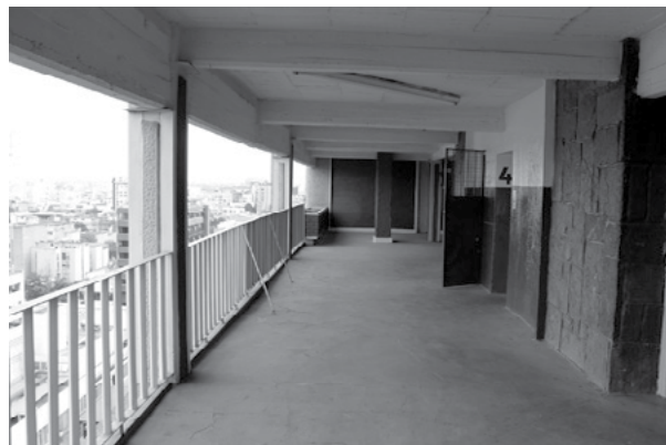
Figura 11. Los núcleos de elevadores de los edificios de 12 niveles del CUPA, localizados en los extremos de cada edificio, brindan una mayor resistencia estructural. Fotografía de Pablo Francisco Gómez Porter, 2015.
