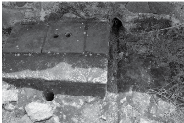
Figura 8. Cubierta de la letrina de la primera celda del aljibe 3. Se pueden ver los dos tubos de aireación de la letrina, al pie de estos, la cañería por la que bajaba el agua para limpiar el inodoro, y a la derecha el tubo de salida del agua del aljibe 3. Fotografía de Alberto Garín.
