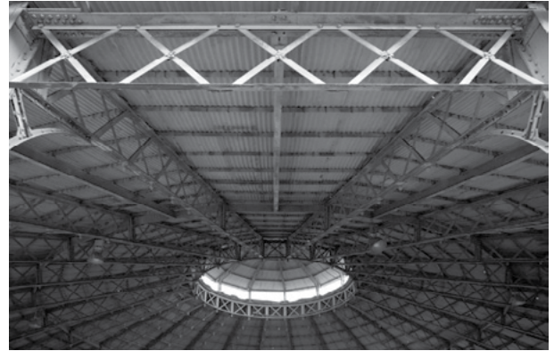
Figura 12. Detalle de la cubierta actual. Fotografía de Roberta Vassallo.
