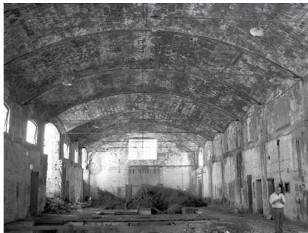
Figura 8. Edificio de máquinas de la Potosina Electric Company, Antonio Prieto, 1903. Fotografía de Mónica Silva, 2014.
