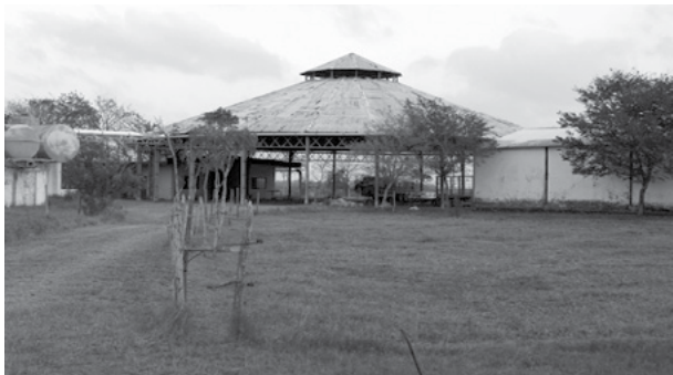
Figura 8. La cubierta en la actualidad, en las afueras de Tampico. Fotografía de Roberta Vassallo.
