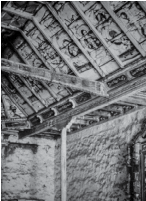
Figura 17. Cubierta trapezoidal de madera, templo de Santa Rosa, en Zacán, Sierra purépecha. Fotografía del Archivo Torres Salomao. Esquema elaborado por Luis Alberto Torres.
