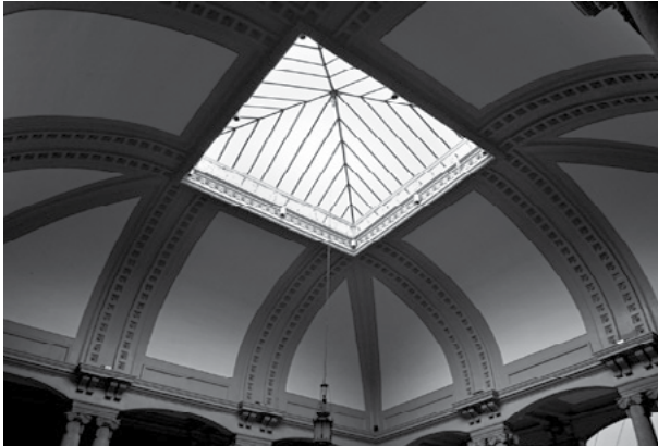
Figura 11. Cubierta y tragaluz del Palacio de Minería. Fotografía de Héctor Pineda, 2014.
