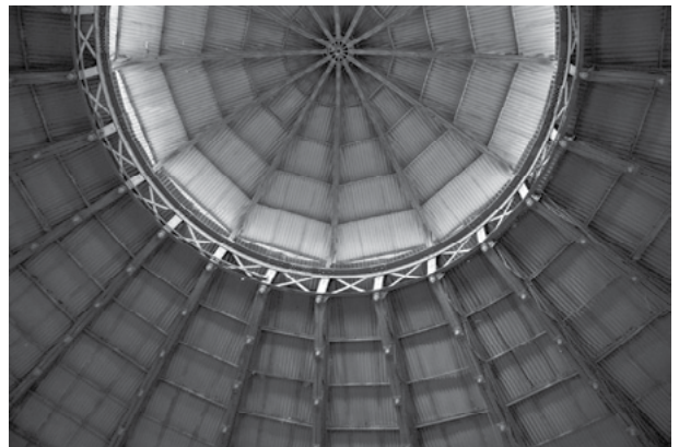
Figura 13. Vista cenital del interior del techo actual. Fotografía de Roberta Vassallo.
