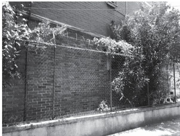
Figura 9. Ladrillos vidriados utilizados en los muros del CUPJ; en la actualidad estos son los únicos que aún conservan su acabado original, dado que los pocos edificios que quedan en pie han sido pintados, borrando por completo la apariencia original del acabado. Fotografía de Pablo Francisco Gómez Porter, 2015.
