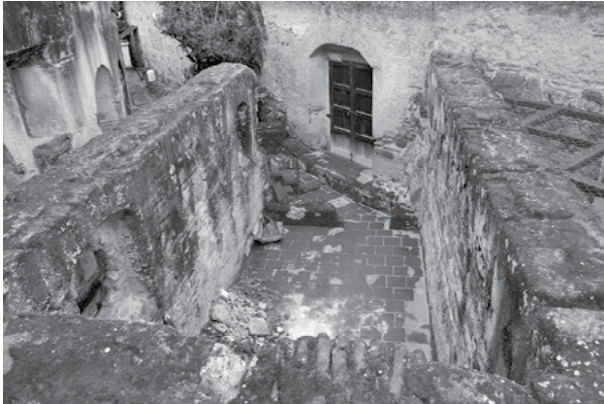
Figura 14. Puerta y pasillo del médico. Se observa cómo el muro que cierra este pasillo a la izquierda se abrió y se habilitaron unas gradas para facilitar la circulación de los visitantes. Fotografía de Loren Lemus.
