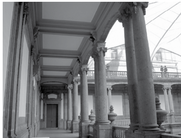
Figura 10. Techumbre del primer nivel, 2014. Fotografía de Leopoldo Rodríguez Morales, 2014.
