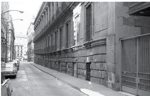
Figura 8. Callejón de la Condesa, antes de la intervención de 1970-1976. El nivel original del edificio no había sido recuperado. Fotografía del ingeniero Alberto Lepe Zúñiga, 1964, colección del AHFM.
