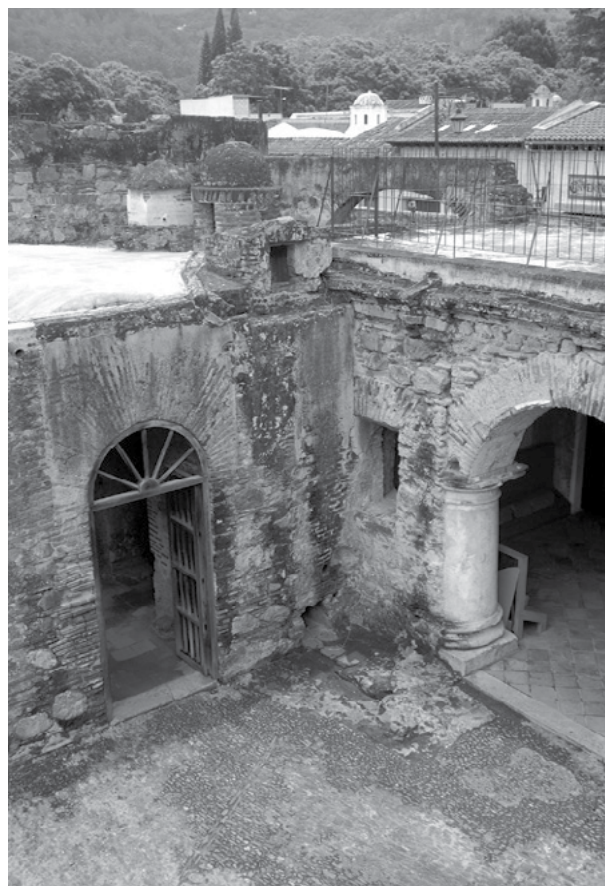
Figura 10. Restos del área de calefacción del ramal C. En la parte superior se ve la torre de agua del ramal C, así como el arco del acueducto del ramal B. En el suelo y contra la puerta del pasillo se pueden observar las improntas de los muros que cerraban este habitáculo de calefacción. En el rincón se ven las cañerías de cerámica y metal por donde entraba el agua a la ducha. Fotografía de Loren Lemus.
