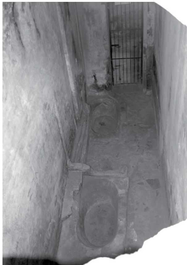
Figura 11. Tinas de la torre circular. A la izquierda de las tinas se ven las acanaladuras para encajar las tuberías de agua caliente y fría. Fotografía de Loren Lemus.
