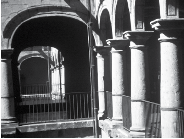
Figura 14. Barandales en el Hospital de Jesús. Fotografía de Guillermo Boils Morales, 2007.
