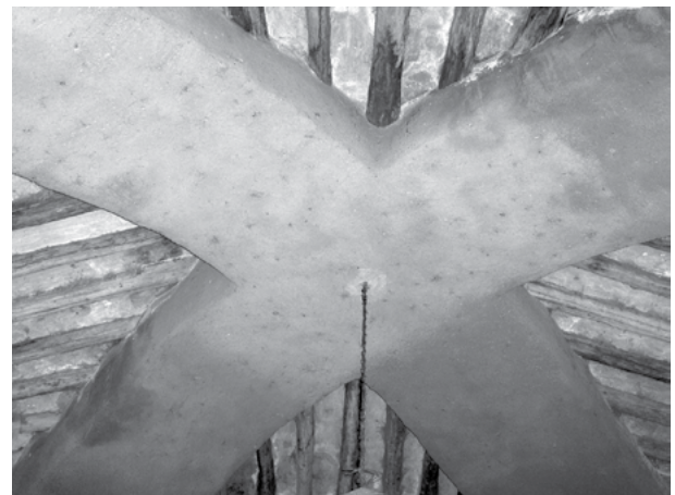
Figura 25. Arcos fajones diagonales y plementería de la cubierta de la noria del ex convento San Bernardino de Sena en Sisal, Valladolid, Yucatán. Fotografía de Manuel Arturo Román Kalisch.
