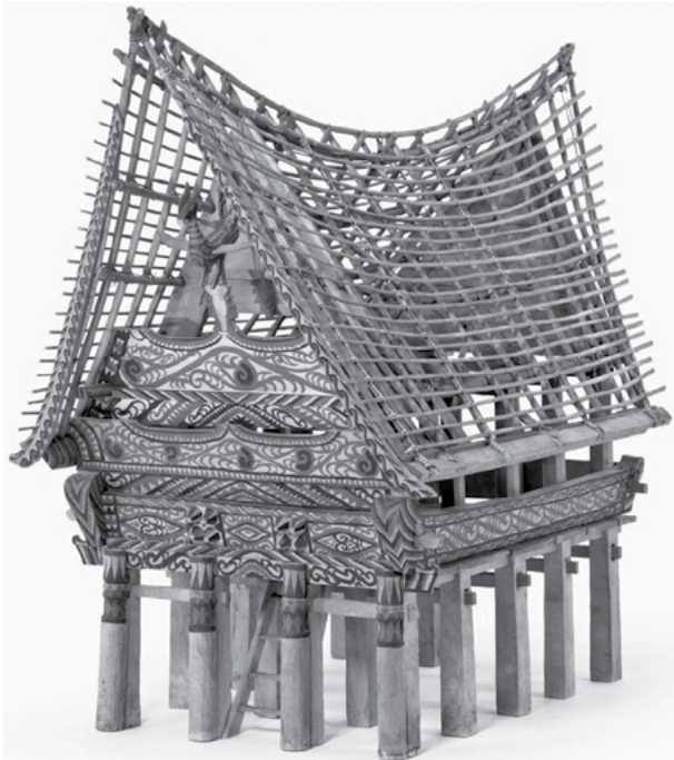
Figura 11. Un esqueleto de postes y barras forma la estructura de una casa "Batak" de Sumatra (Indonesia). Maqueta sin escala, 1922. Fotografía del Deutsches Museum.
