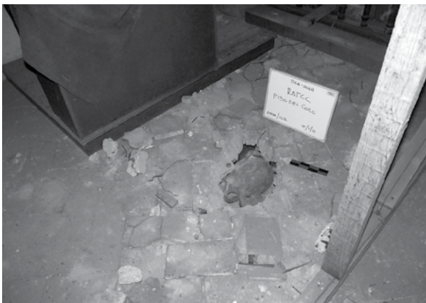
Figura 6. Por debajo del piso de ladrillo, jarra de cerámica colocada horizontalmente, como parte del relleno aligerado en coro, 2012.
