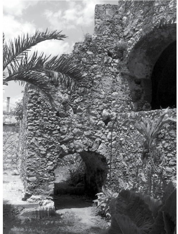
Figura 24. Pilar y arbotante de la noria del ex convento San Bernardino de Sena en Sisal, Valladolid, Yucatán. Fotografía de Manuel Arturo Román Kalisch.
