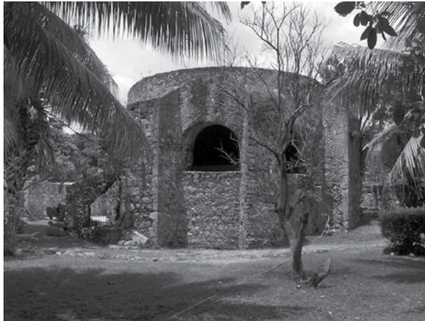
Figura 23. Estructura y cubierta de la noria del ex convento San Bernardino de Sena en Sisal, Valladolid, Yucatán. Fotografía de Manuel Arturo Román Kalisch.
