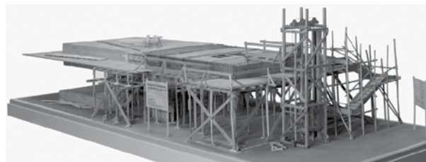
Figura 6. Maqueta que muestra la construcción, con concreto armado, del Café del Estadio de Nuremberg (1928). Fotografía del Deutsches Museum.
