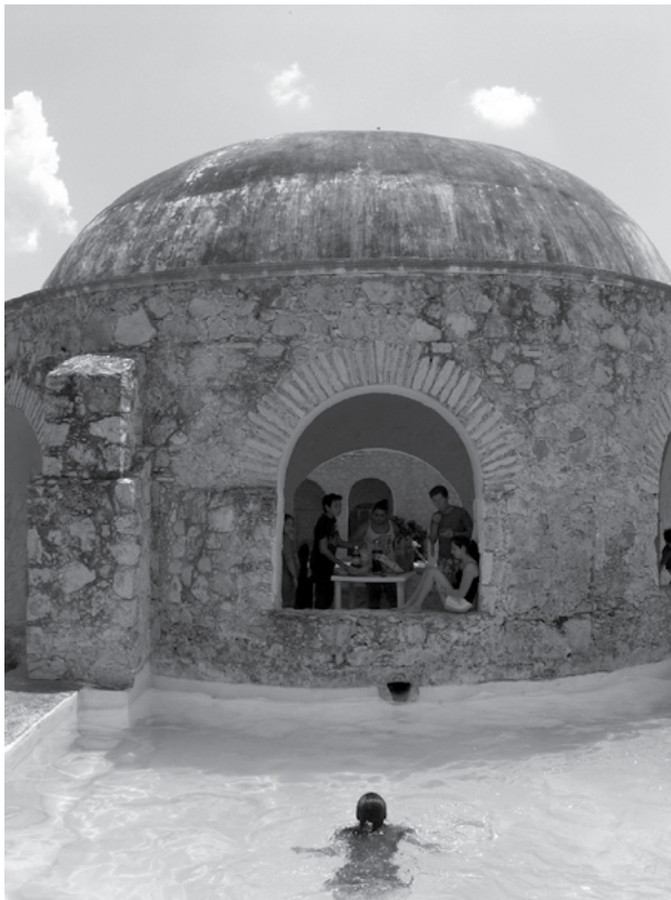
Figura 30. Tanque de almacenamiento de la noria del ex convento San Francisco en Conkal, Yucatán. Fotografía de Manuel Arturo Román Kalisch.
