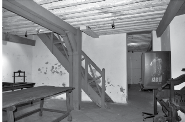
Figura 14. Escalera de un tramo que comunica con la pieza alta de una de las accesorias de "taza y plato" del Colegio de las Vizcaínas. De igual forma se aprecia la viguería del entresuelo. Fotografía de Gabriela Sánchez Reyes.
