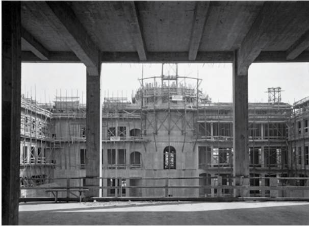
Figura 2. Vista de la obra negra del edificio de concreto armado del Deutsches Museum. Fotografía del Deutsches Museum.
