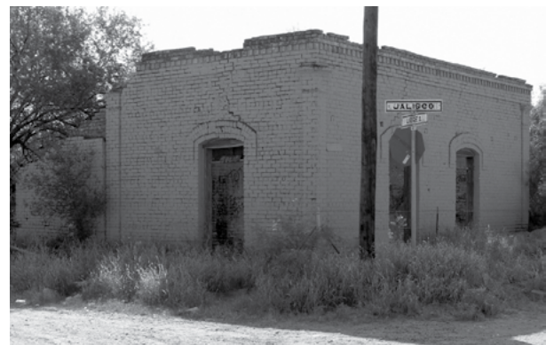
Figura 7. Salón ubicado en la plaza principal de Colombia, Nuevo León. En este caso se observa el empleo de ladrillo cocido a alta temperatura; es difícil resolver si se trataría de material proveniente de ladrilleras estadounidenses, porque en ambos lados del río Bravo se formó una tradición de fabricación y empleo de dicho material desde al menos finales del siglo XIX. Fotografía de Alejandro González Milea, 2009.
