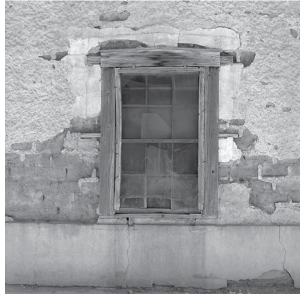
Figura 9. Marco de ventana en Villa Ahumada, Chihuahua. Otro aspecto de la influencia estadounidense está dado por la construcción de marcos de puertas y ventanas, con maderas predimensionada y proveniente de aserraderos. Ahora, en lugar de las pesadas jambas y dinteles de madera cortados con hacha, empiezan a usarse barros y tablas cortadas conforme a “modelo” y con diseños clásicos; desde luego a finales del siglo XX también comenzaron a omitirse los dovelados en dintel de adobe o piedra. Fotografía de Alejandro González Milea, 2014.
