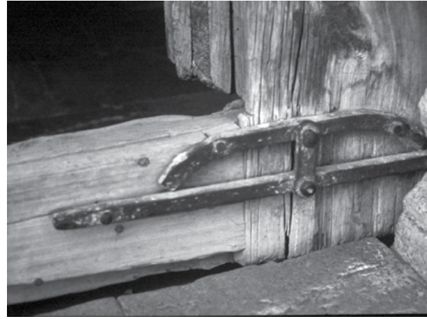
Figura 15. Refuerzo de hierro en portón. Templo de San Miguel, Huejotzingo, Puebla. Fotografía de Guillermo Boils Morales, 2011.
