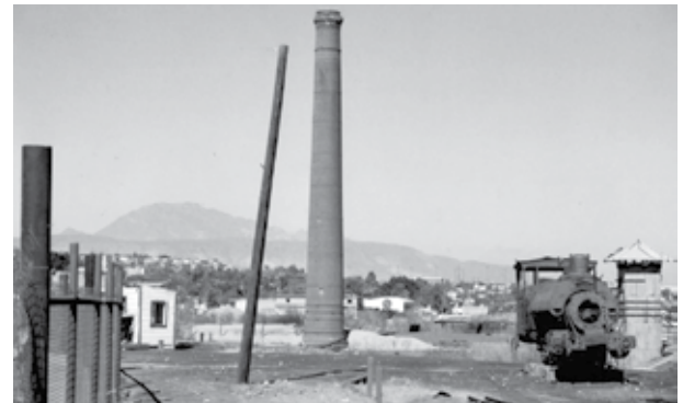
Figura 17. Estado actual de deterioro en el que se encuentra el patrimonio industrial de Santa Rosalía. Fotografía de Enrique Esteban Gómez, 2013.
