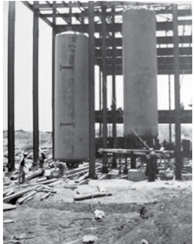
Figura 9. Colocación de los hervidores. Uno de éstos presenta lo que podría ser la marca o el nombre de otra compañía, lo que podría indicar su posible reutilización. Colección Alberto Lenz Krahl.
