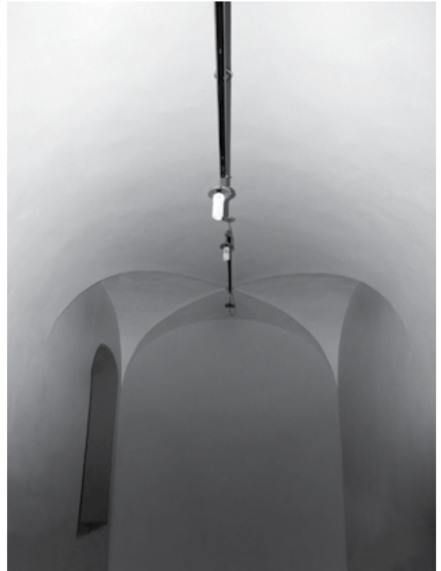
Figura 7. Sala de ensaye y de fundición ubicada en la crujía contigua al cubo de la escalera. La parte del fondo está cubierta por una bóveda de arista y la segunda por otra de cañón corrido. Ésta se comunicaba en el otro extremo con el espacio que ahora está detrás de su muro sur, en el que estuvo el horno de fundición. Fotografía de Alicia Cordero, 2012.
