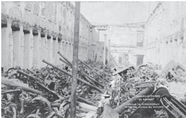
Figura 9. "Interior del departamento de telares después del incendio", sala de telares primer piso, sala de hilados y carretilleros segundo piso, Yáñez, s/f, Culiacán. Fondo particular Miguel Tamayo.
