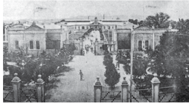
Figura 10. Entrada principal de la fábrica. Se observan los jardines laterales con sus fuentes. En los edificios de entrada se colocaron dos banderines que decían: Jorge Unna y Cía. Se aprecian los jardines centrales, y al fondo el edificio principal con el reloj; Tomás Calvillo Unna, "Jorge Unna. Arte y empresa potosina. San Luis cuatro siglos de esfuerzo", en Pulso , 19 de marzo de 1992.
