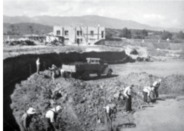
Figura 2. Se comienza a delinear la tina que contendrá varios millones de litros cúbicos de agua para la elaboración de la celulosa. 1955. Colección Alberto Lenz Krahl.
