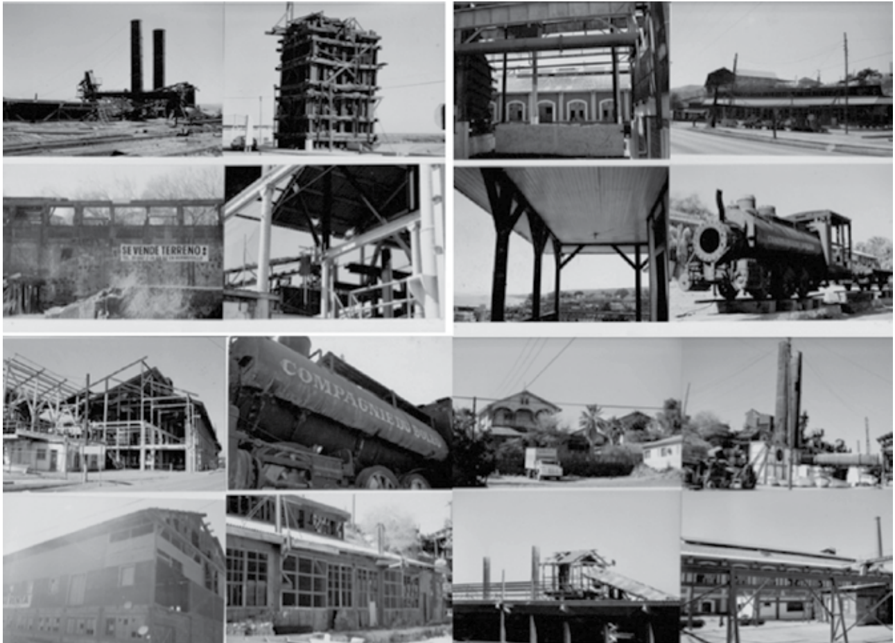
Figura 25. Serie de imágenes que muestra el estado actual de deterioro en el que se encuentra el patrimonio industrial de Santa Rosalía. Fotografías de Enrique Esteban Gómez, 2013.
