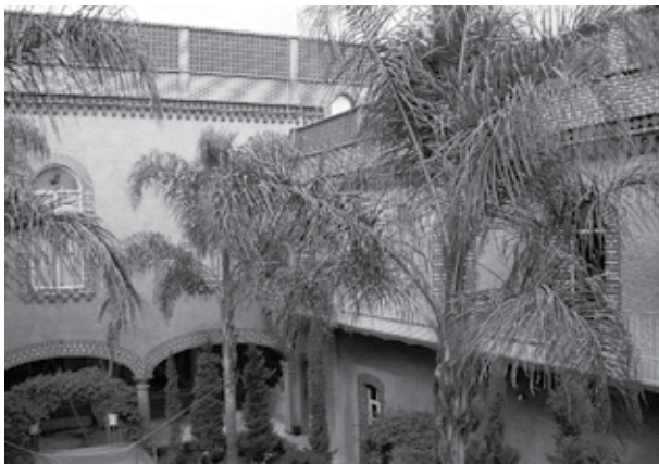
Figura 9. Detalle del claustro en el actual monasterio de Santa Mónica, 2004.
