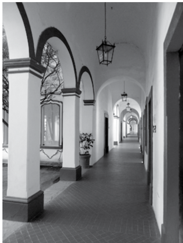
Figura 14. Estado actual del Centro Cultural el Refugio, antiguo hospital y casa de ejercicios espirituales de San Pedro Tlaquepaque. Fotografía de Tomás de Híjar Ornelas, 2014.
