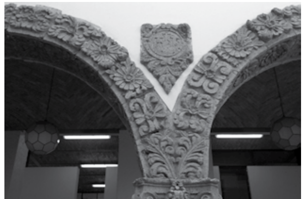
Figura 8. Claustro de Los Ángeles; detalle de los arcos.
