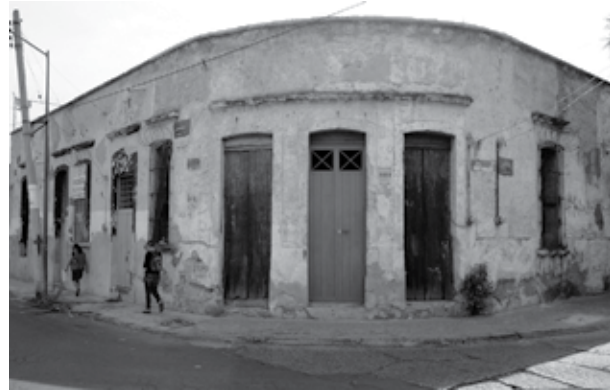
Figura 17. Aspecto de una vivienda ruinoso en la calle de J. Luis Verdía, a la vera de la cual vivieron las dominicas durante la guerra cristera. Fotografía de Tomás de Hijar Ornelas, 2014.
