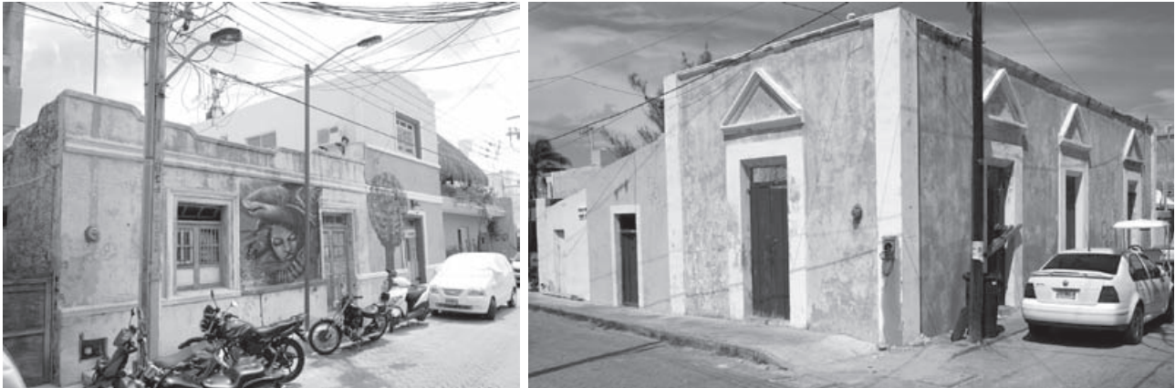
Figura 34. Arquitectura construida con muros de piedra en Isla Mujeres. Fotografías de David Antonio Pérez Fernández.
