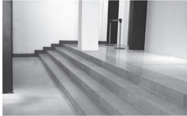
Figura 21. Imagen que muestra la obra ya concluida y los cuatro escalones o peldaños, sin pasamanos para el acceso de discapacitados. Irónicamente, el argumento para colocar dicho elevador sería para dar servicio a imposibilitados y movimiento de colecciones; no tiene rampa, sino cuatro escalones. Fotografía de Elsa Hernández Pons.
