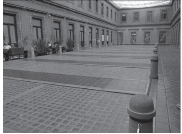
Figura 19. Techo de la Tesorería de Palacio Nacional actual, que combina franjas de piso de barro rojo y áreas de bloques de vidrio, supuestamente resistentes, con un pasillo perimetral en todo el espacio, y que permiten, una iluminación amplia al espacio o cuarto inferior. Hoy en día se evita que el público camine sobre este sistema. Fotografía de Elsa Hernández Pons, 2014.
