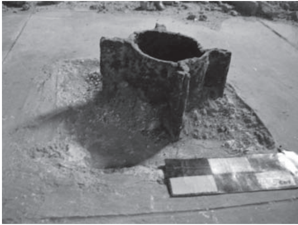
Figura 23. Columna recortada en su base, para introducir un nuevo piso dentro de Moneda 13. Elsa Hernández Pons y Braulio Pérez Mora, "Columnas metálicas en la arquitectura de Moneda 13", en prensa. Fotografía de Elsa Hernández Pons.
