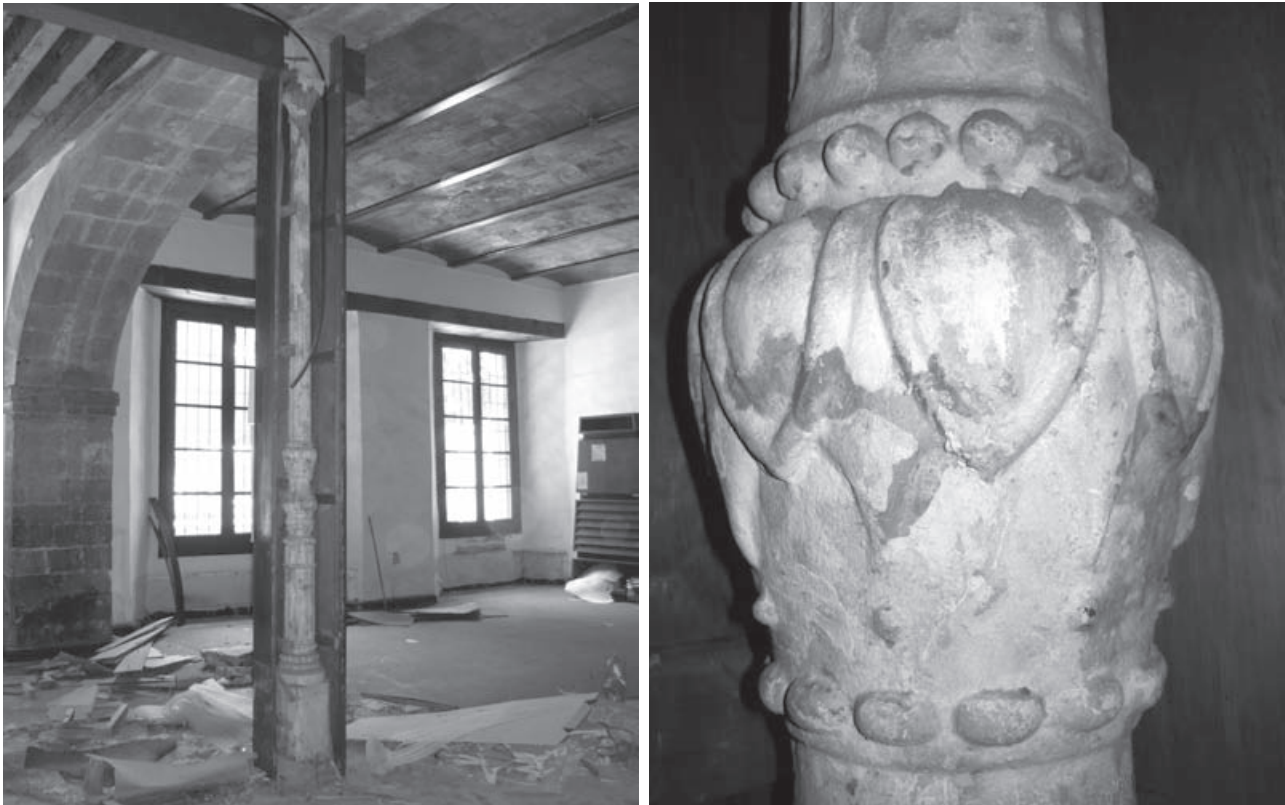
Figura 24. Columna metálica del salón introductorio del MNA y acercamiento de la misma, durante el proceso de liberación por los arquitectos del MNC, muchos años ocultas por decisiones administrativas. Fotografías de Elsa Hernández Pons.
