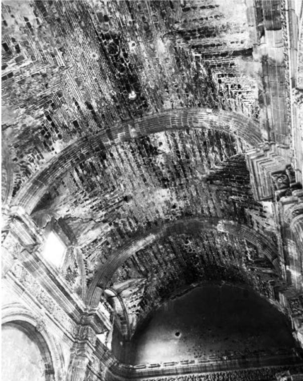
Figura 11. La bóveda de tezontle alternada con ladrillo, con lunetos, del ex templo del Hospital de San Lázaro, se hallaba deteriorada pero hoy en día está en buenas condiciones. Es similar en diseño a la del templo de San Lorenzo: una bóveda de cañón corrido con lunetos y arcos torales. Fotografía de Leopoldo Rodríguez Morales, 2016.
