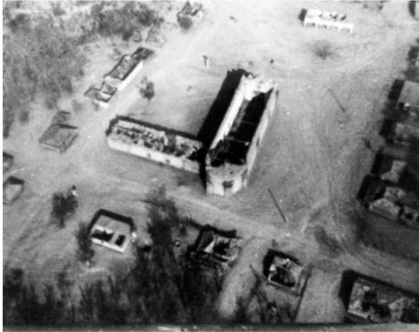
Figura 12. Francisco León después de la erupción del 28 de marzo de 1982. En la imagen se observan los daños causados en el conjunto conventual dominico en la primera erupción. Fotografía del AHEC, exp. de Francisco León, AH/F/82/03.
