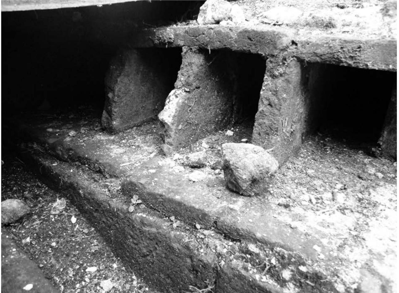
Figura 6. Sistema constructivo a base de ladrillo que provoca el aligeramiento en los rellenos de las bóvedas, además de aislamiento térmico e hídrico. Fotografía de Daniel Pastrana.
