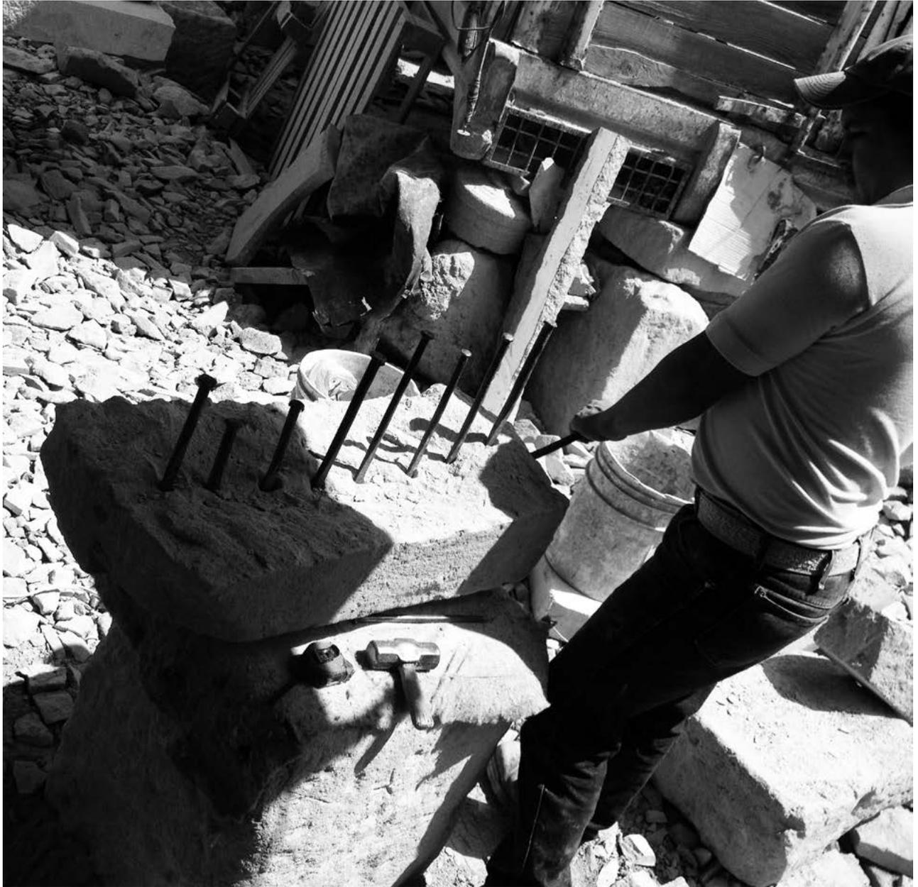
Figura 8. La actividad de “cuñear la piedra” implica colocar cuñas o cinceles con una separación de 10 cm y golpear cada uno de ellos, separando los bloques de una manera lineal. Fotografía de Rocio Ivet Oros Guel, 15 de abril de 2015.
