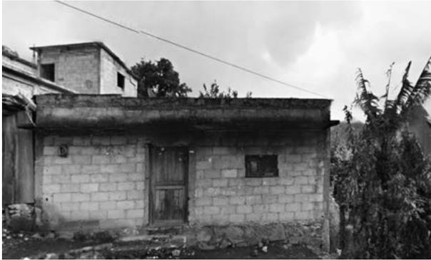
Figura 8. Viviendas edificadas con *block* "zoque" en Tapalapa. Fotografía recuperada de: <<https://www.google.com.mx/intl/es/earth>>.
