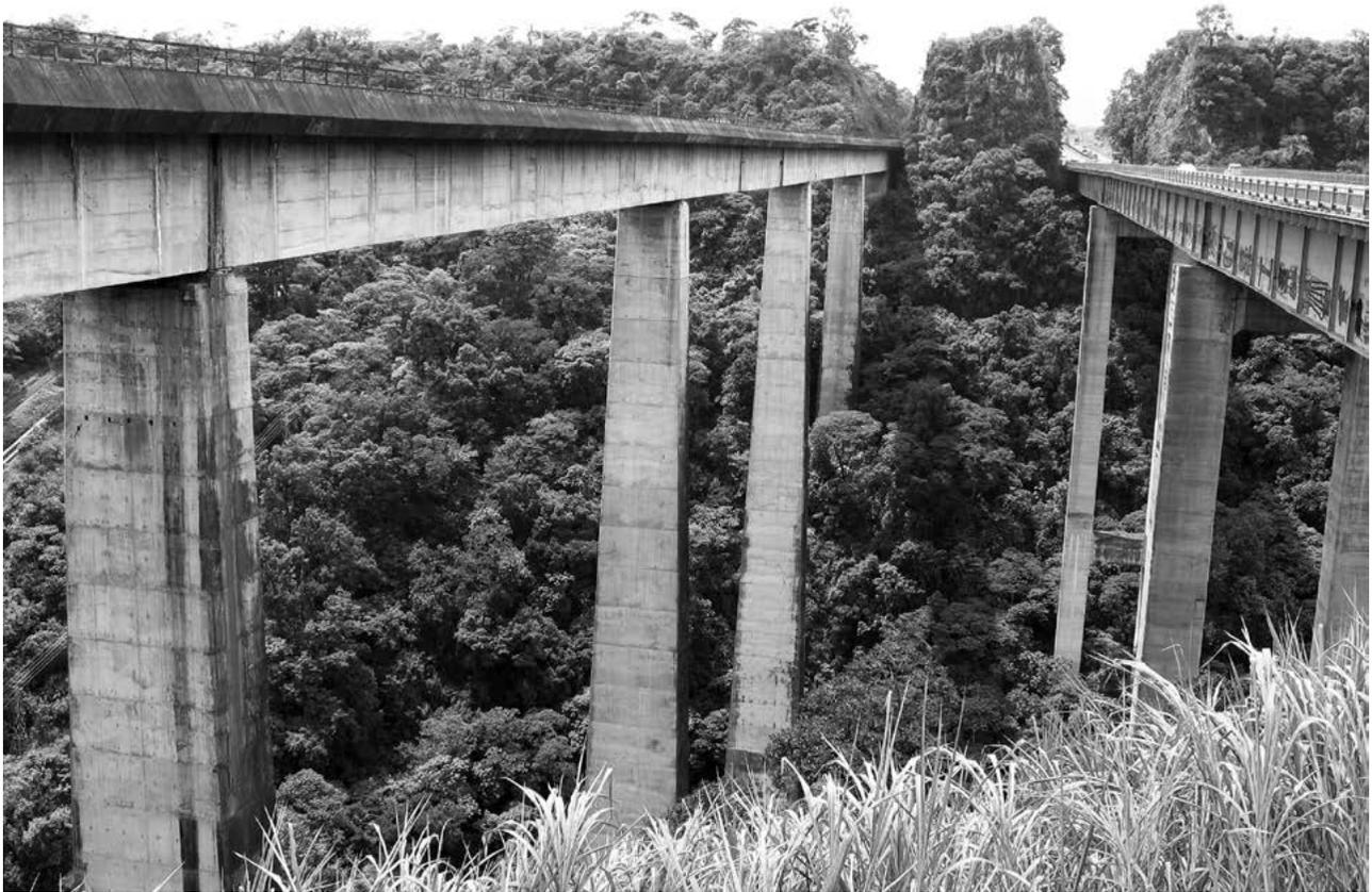
Figura 11. Los nuevos puentes de Metlac: de concreto para el ferrocarril (izq.) y de acero para la autopista (der.). Fotografía de Dirk Bühler.
