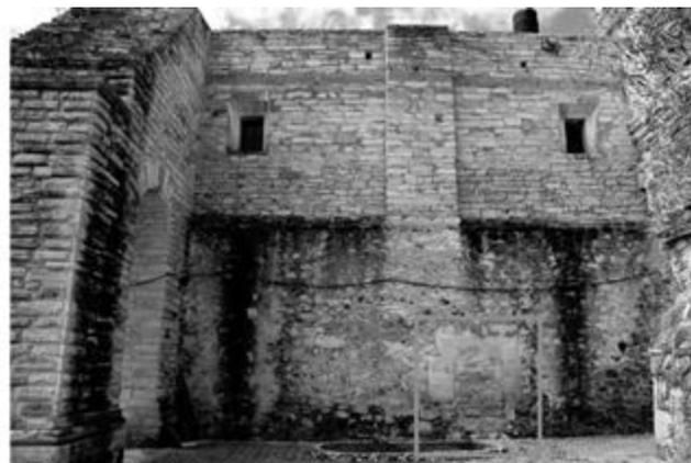
Figura 18. A la izquierda interior de la capilla del Señor de los Trabajos, Fotografía Julio Martínez Bronniman, 2012. A la derecha muro poniente donde se puede ver la diferencia de materiales, los contrafuertes y el vano tapeado. Fotografía Yunuen Maldonado Dorantes, 2011.
