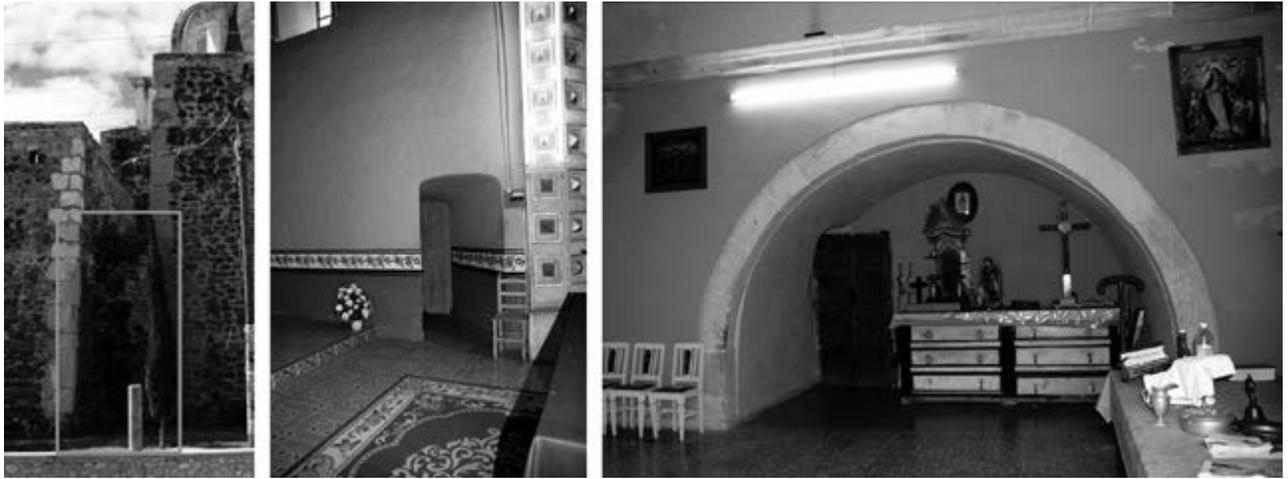
Figura 15. En la imagen de la izquierda se advierte el relleno que se colocó entre las dos construcciones para generar el pasillo que las comunica; en la fotografía del centro se observa el vano que fue horadado en el muro del presbiterio para permitir el acceso hacia la sacristía y en la última se indica el arco que se formó con el relleno en el muro de la sacristía y que vincula ambos espacios. Fotografías Yunuen Maldonado Dorantes, 2011.
