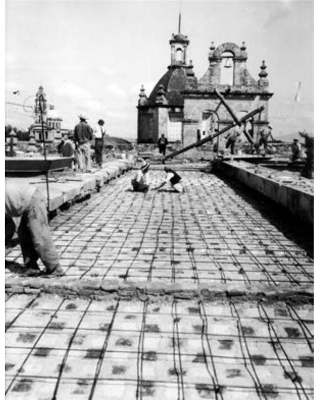
Figura 9. Museo de Guadalajara, colocación del emparrillado para una losa de concreto en uno de los techos del edificio, 1925, Fototeca Constantino Reyes Valerio, CNMH-INAH, clasif. 0120-67.
