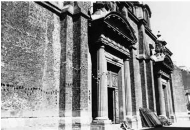
Figura 15. Fachada del templo con muros de tezontle sin enlucido, sobre los que se apoyó una parte de la reja entre las dos portadas de acceso. Foto de la autora ca. 1980.
