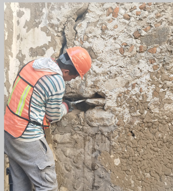
Imagen 14. Liberación de la mampostería para coser el muro
