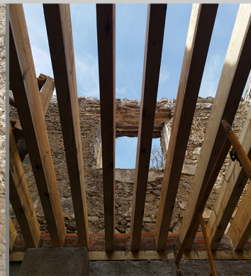
Imagen 16. Colocación de viguería de madera de pino respetando los vestigios existentes
