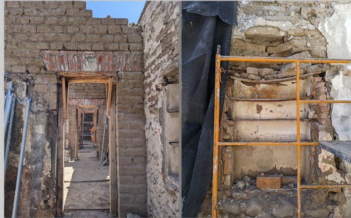
Imagen 19. Reintegración de dinteles de puertas en primer nivel
