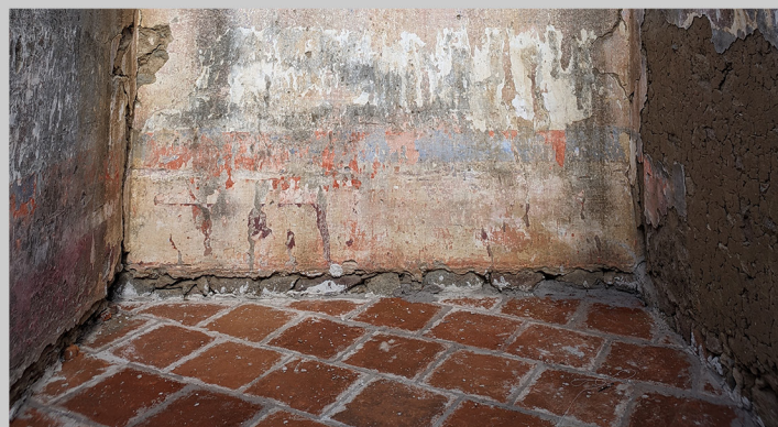
Imagen 17 Colocación de cuarterón de barro para losa de entrepiso
