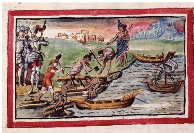
Construcción de bergantines. Códice Durán , siglo XVI, Biblioteca Nacional de España. [ https://nodoarte.com/2017/02/15/historia-de-las-indias-de-nueva-espana-e-islas-de-tierra-firme-diego-duran-1587-ilustraciones/ ]
