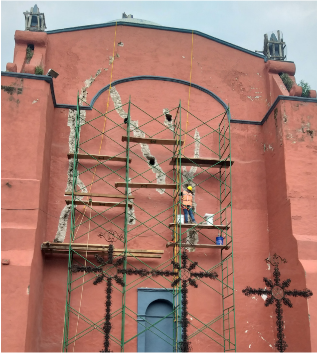
Trabajos de restauración del inmueble, Parroquia de San José, Tlaxcala, Tlaxcala. Año 2022.
